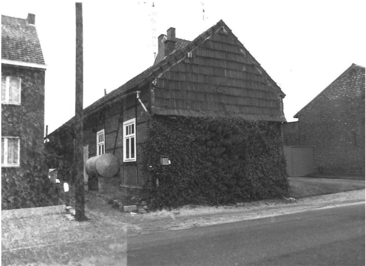
Figuur 18: Foto vastgesteld bouwkindig element id 22130 langgestrekte hoeve (bron geoportaal 2017)
