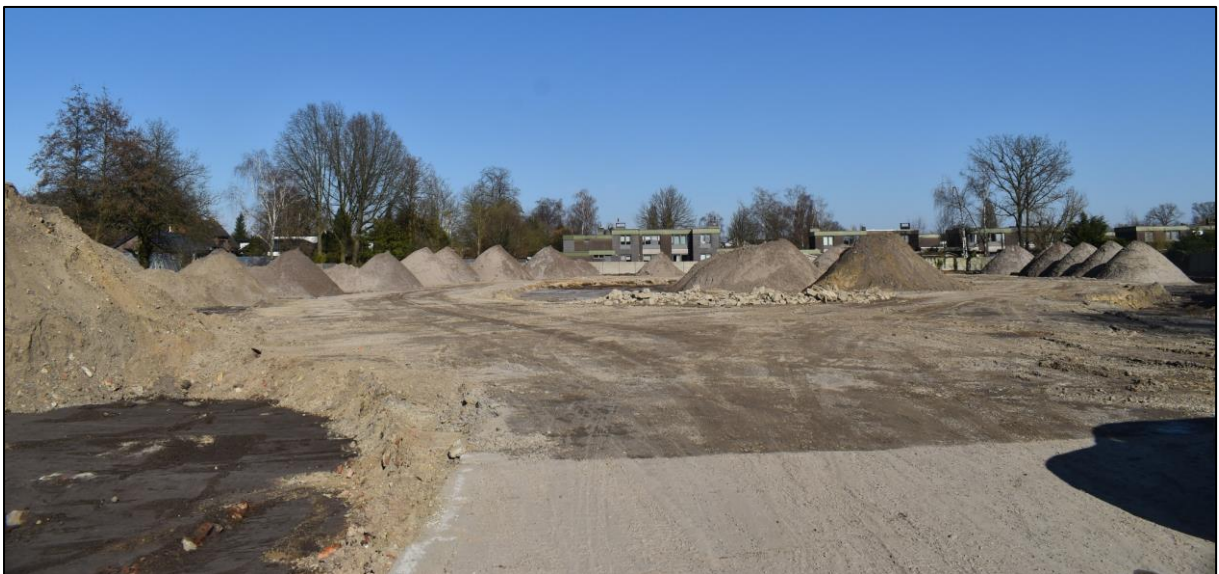
Afb. 21: Zicht op het centrale deel van perceel 645G3 vanuit de toegangspoort in het westen (Bron: ARON bv, dd. 6/03/2025, 2025C46).
