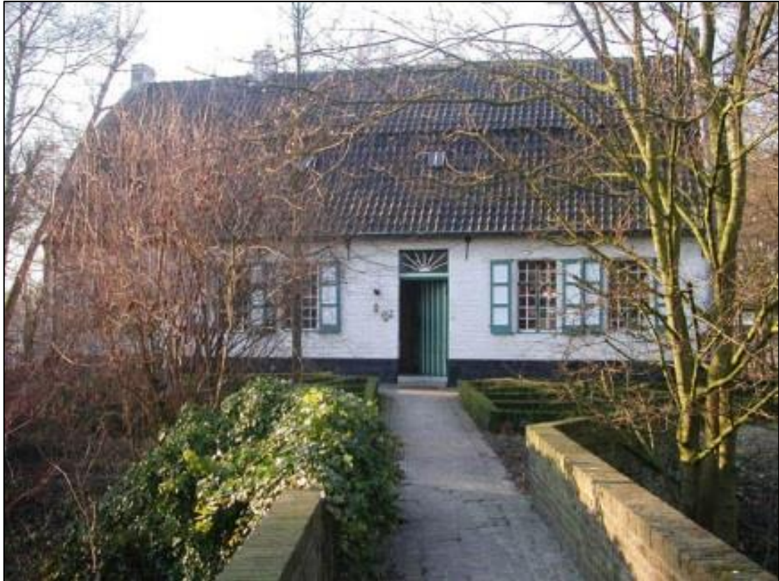
Figuur 22: Hoeve Priesterage (bron: Inventaris bouwkundig erfgoed, ID 8o888)
