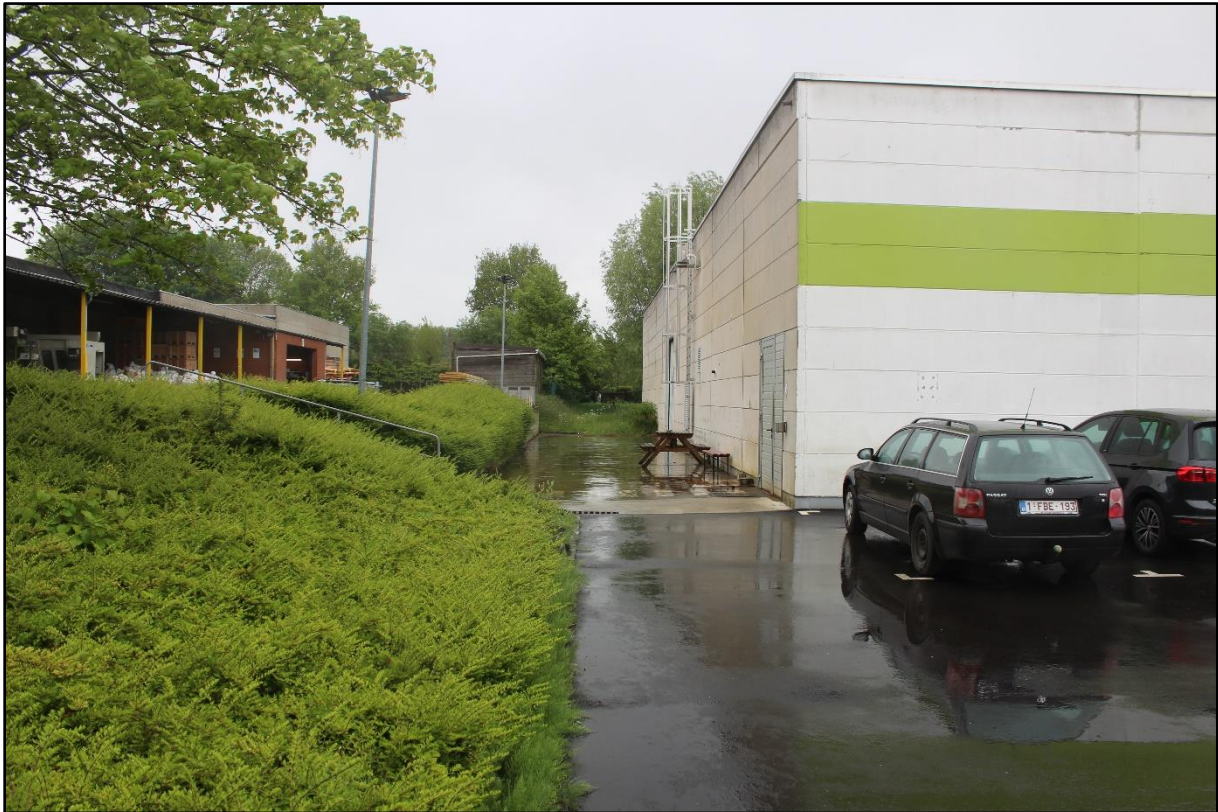
Figuur 4 Zicht op het niveauverschil tussen Albert Dehemlaan 1 (links) en Albert Dehemlaan 1a (rechts). Het niveauverschil bedraagt 1,3m (foto aangeleverd door de initiatiefnemer).
