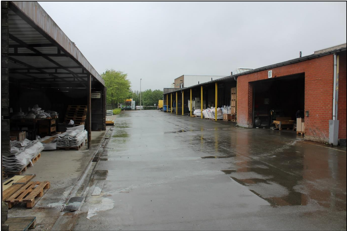
Figuur 2 Zicht op de bestaande asfaltverhardingen (foto aangeleverd door de initiatiefnemer).
