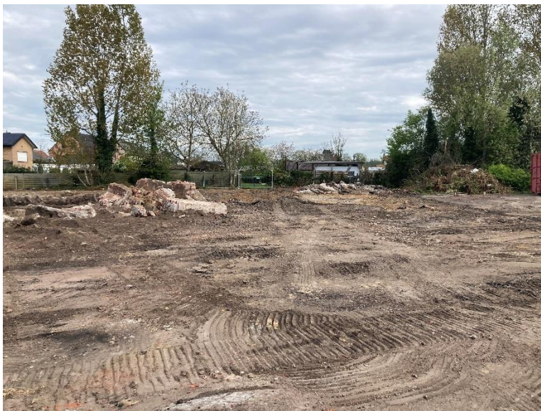
Figuur 9: Zicht op een verharde zone, na het verwijderen van de verhardingen (©INDAR bv)
