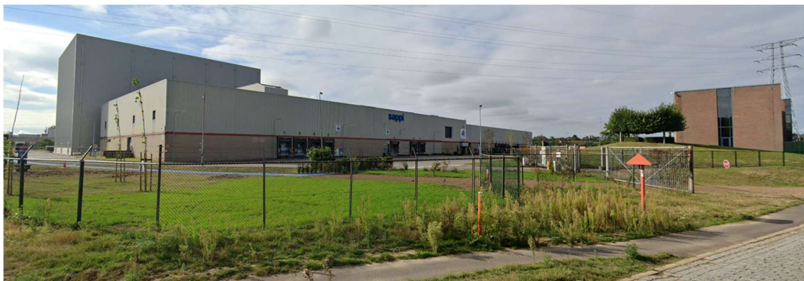
Fig. 1.9: Zicht vanuit het noordoosten op de aanwezige gebouwen en verhardingen (@ Google Maps, opnamedatum september 2020).
