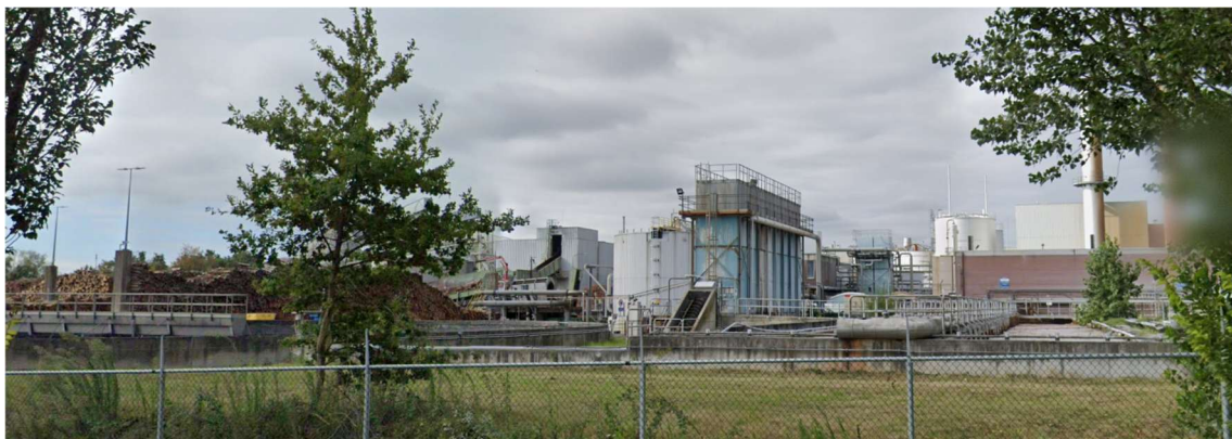
Fig. 1.10: Zicht vanuit het oosten op de aanwezige gebouwen en verhardingen (@ Google Maps, opnamedatum september 2020).
