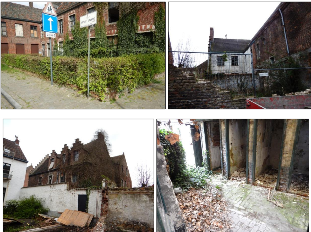
Figuur 42: Enkele foto's die de ontoegankelijkheid van het terrein voor de nodige graafwerken aantonen. 132
