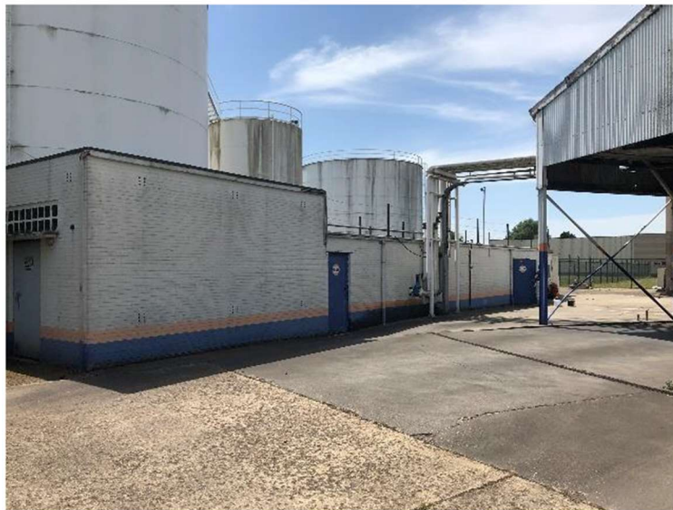
Fig. 1.6: Cisternen vanuit noordoostelijke hoek.
