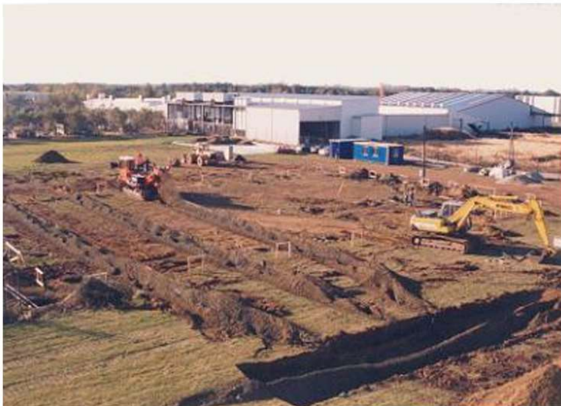
Fig. 1.53: Aanleg drainagesleuven (© Bouwen en Milieu nv 1996).
