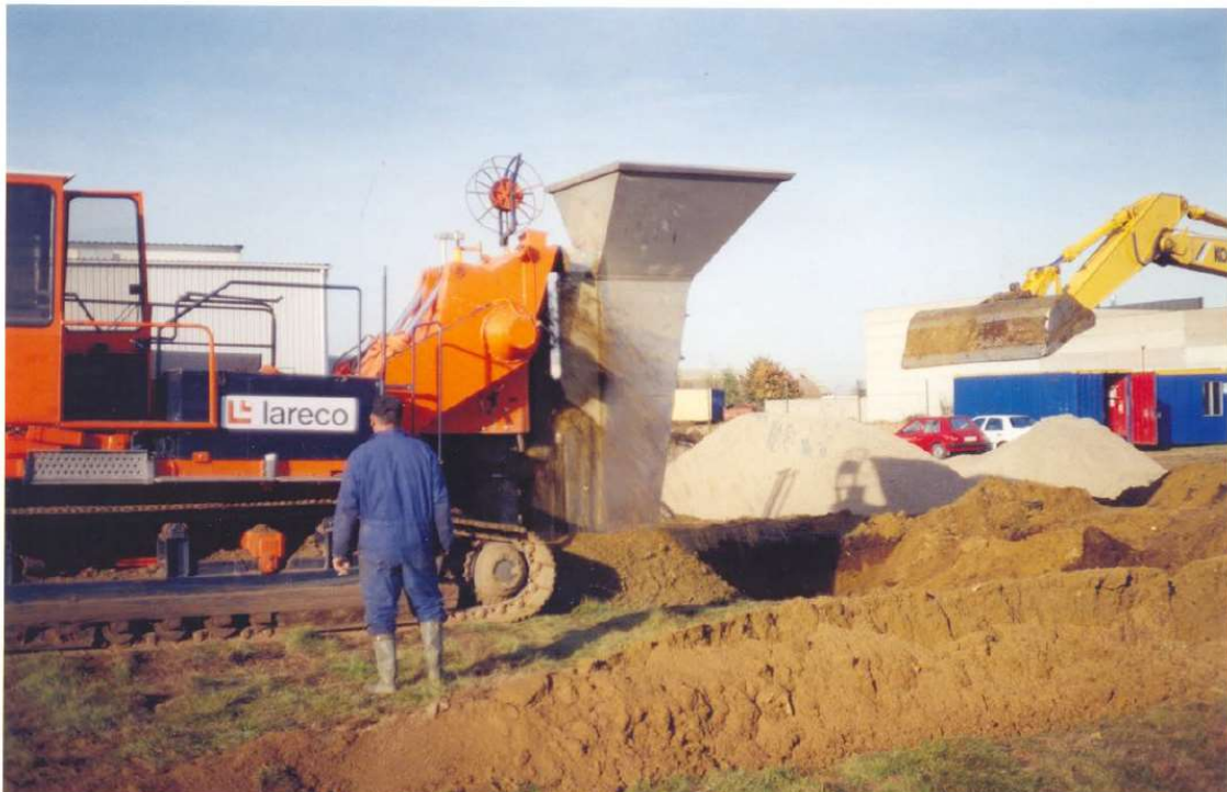
Fig. 1.55: Aanleg drainagesleuven (© Bouwen en Milieu nv 1996).
