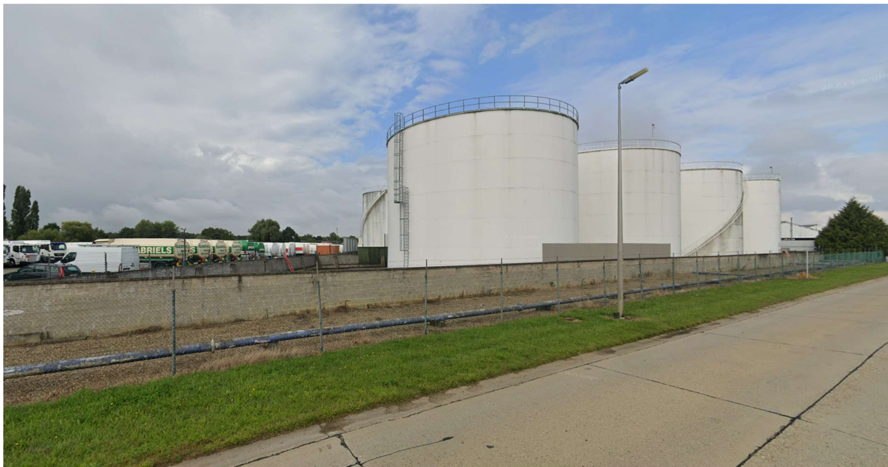
Fig. 1.13: Terreinsituatie in 2023 ten noorden van het kantoorgebouw (© Google Streetview).
