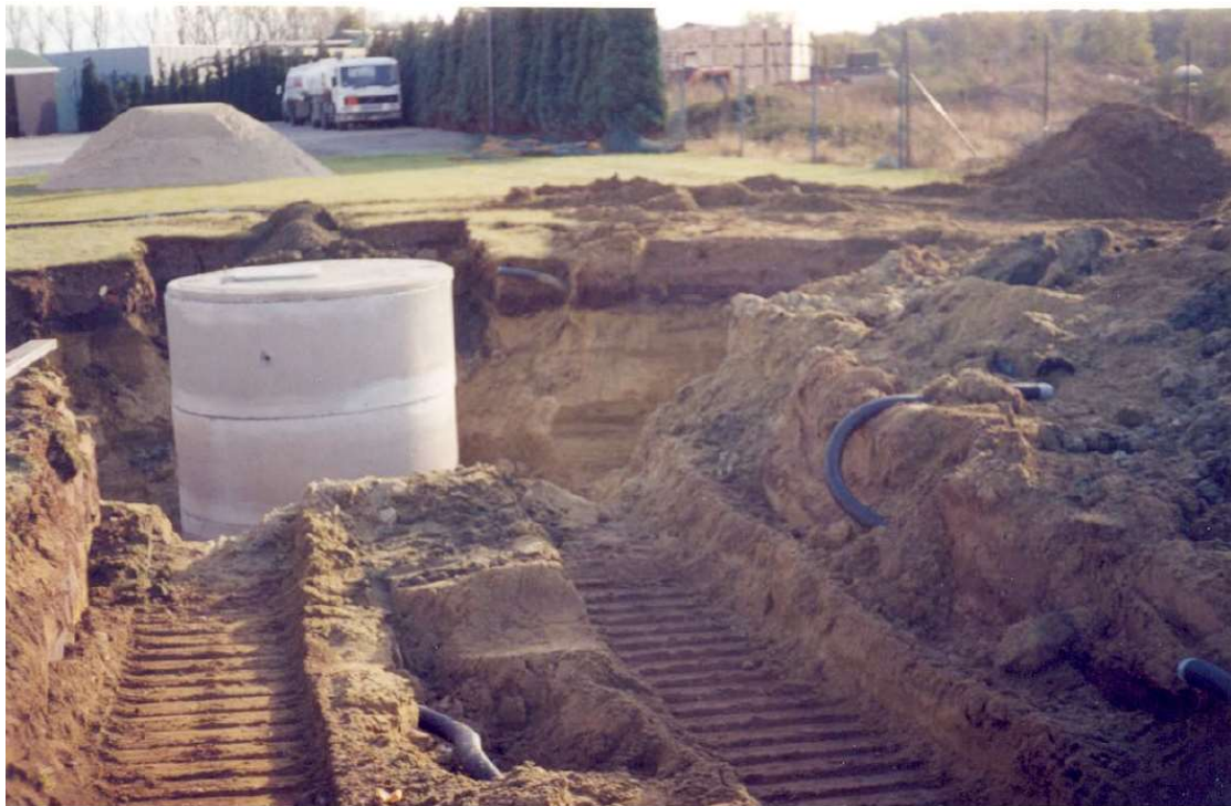
Fig. 1.54: Aanleg centrale pompput met skimmersysteem (© Bouwen en Milieu nv 1996).
