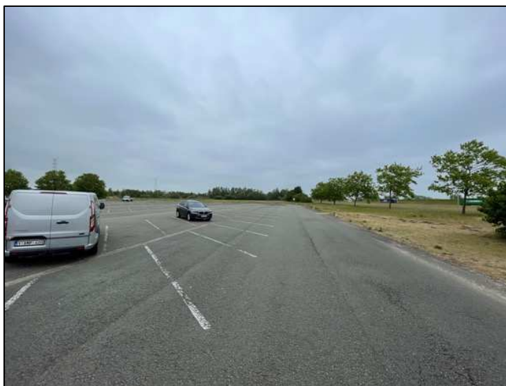
Figuur 1: Foto vanop de parkeerplaats getrokken in noordelijke richting 4
