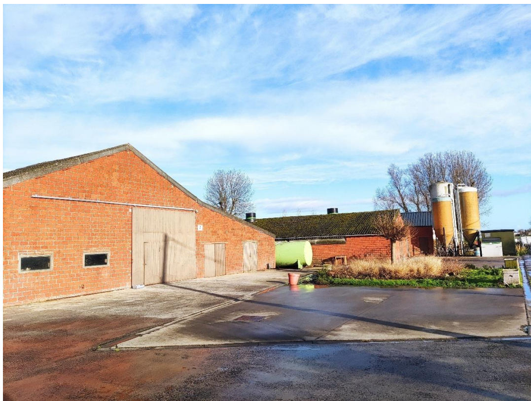
Figuur 3: Foto van de zuidoostelijke hoek van het terrein (te slopen) (beeld van de initiatiefnemer)
