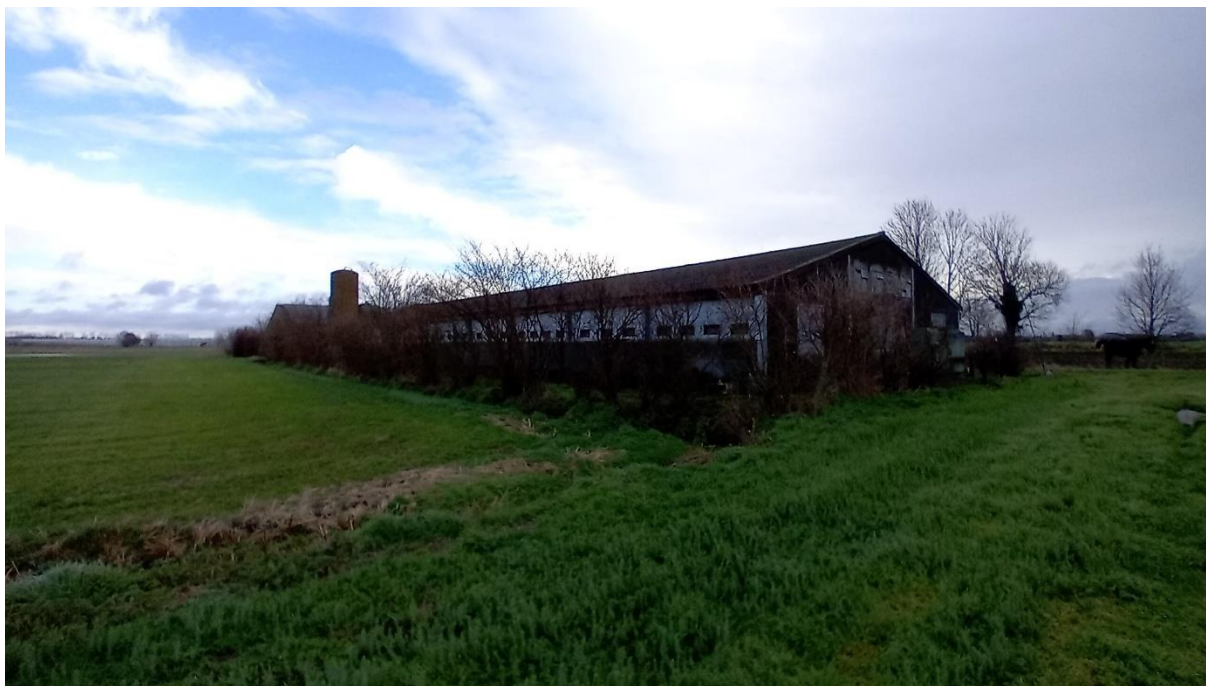
Figuur 6: Foto van de noordwestelijke hoek van het bebouwde terrein (te slopen gebouwen langs te dempen gracht) (beeld van de initiatiefnemer)
