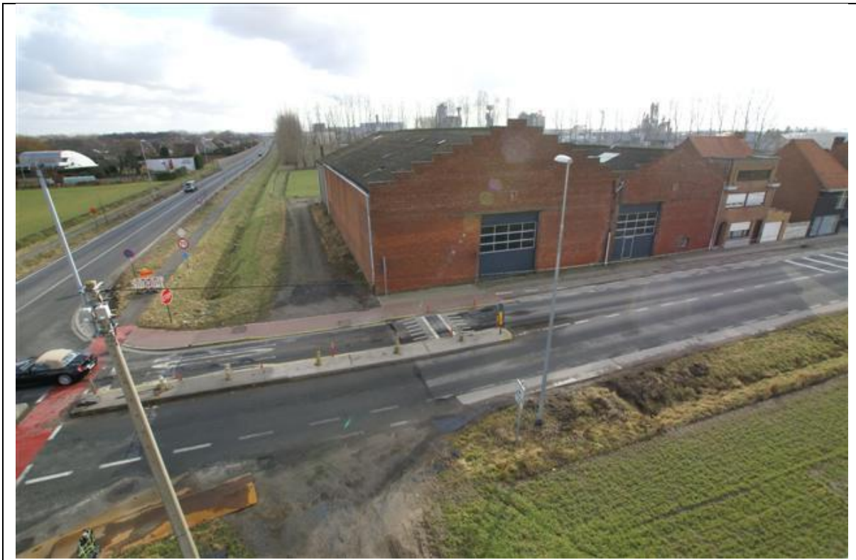
Figuur 7: Foto reeds aanwezige loodsen op het terrein met links de verharde inrit (Bron: Opdrachtgever 2017)
