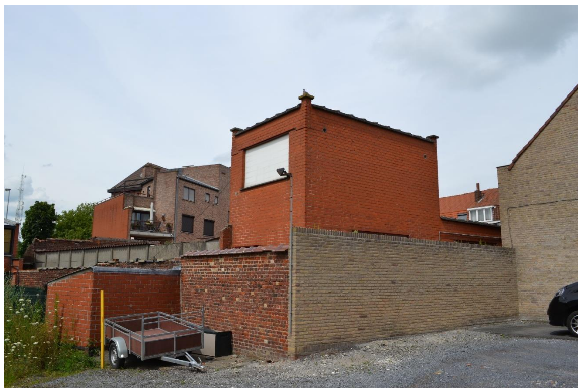
Figuur 6: Foto van de muren op de grens van het plangebied (aangebracht door de initiatiefnemer)
