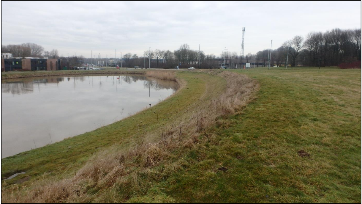
Figuur 40: Ten westen van het terrein is een duidelijke uitgraving waarneembaar die voor een groot stuk opgevuld is met water.
