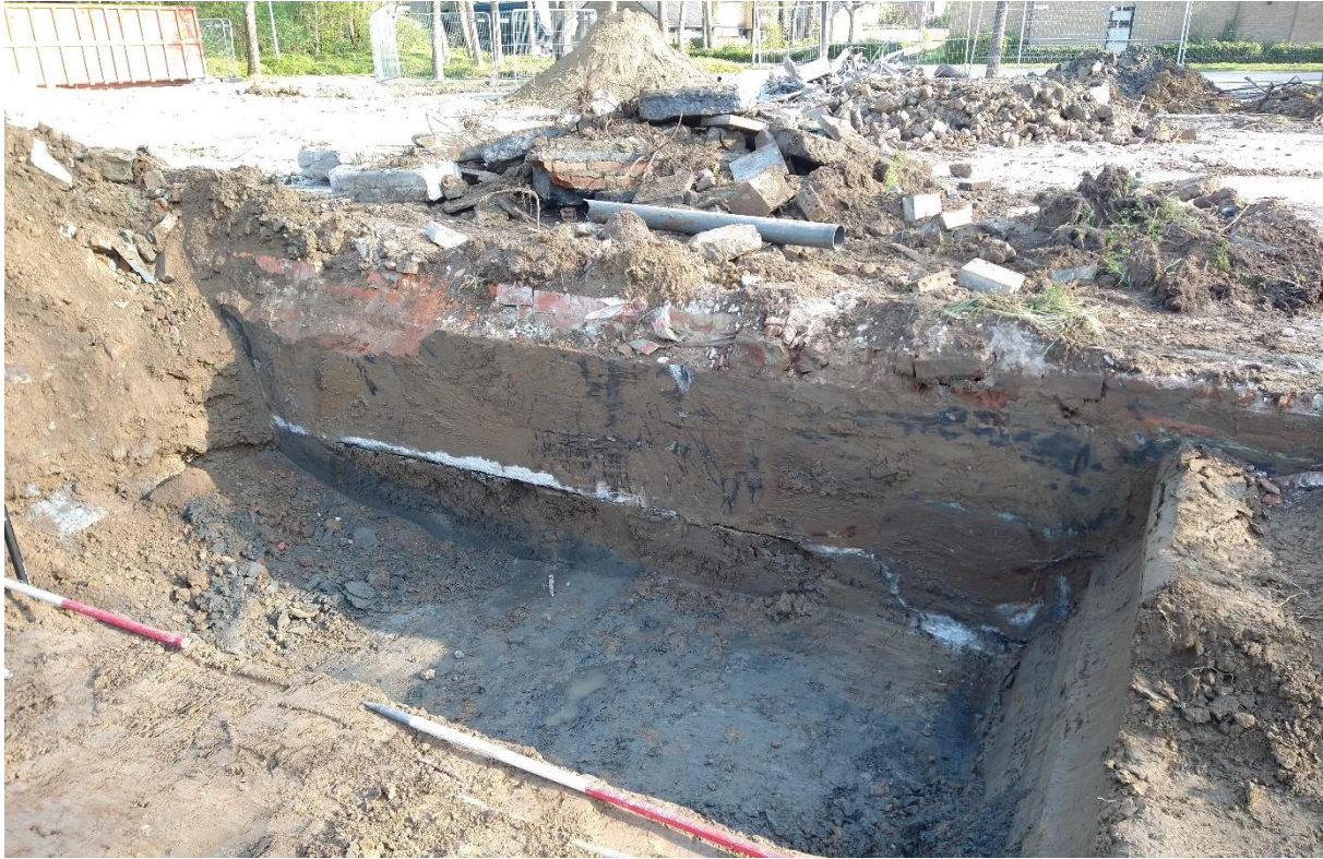
Figuur 29. Profiel 601: de diepte van de ringfundering van de huizen reikte tot 70cm diepte.
