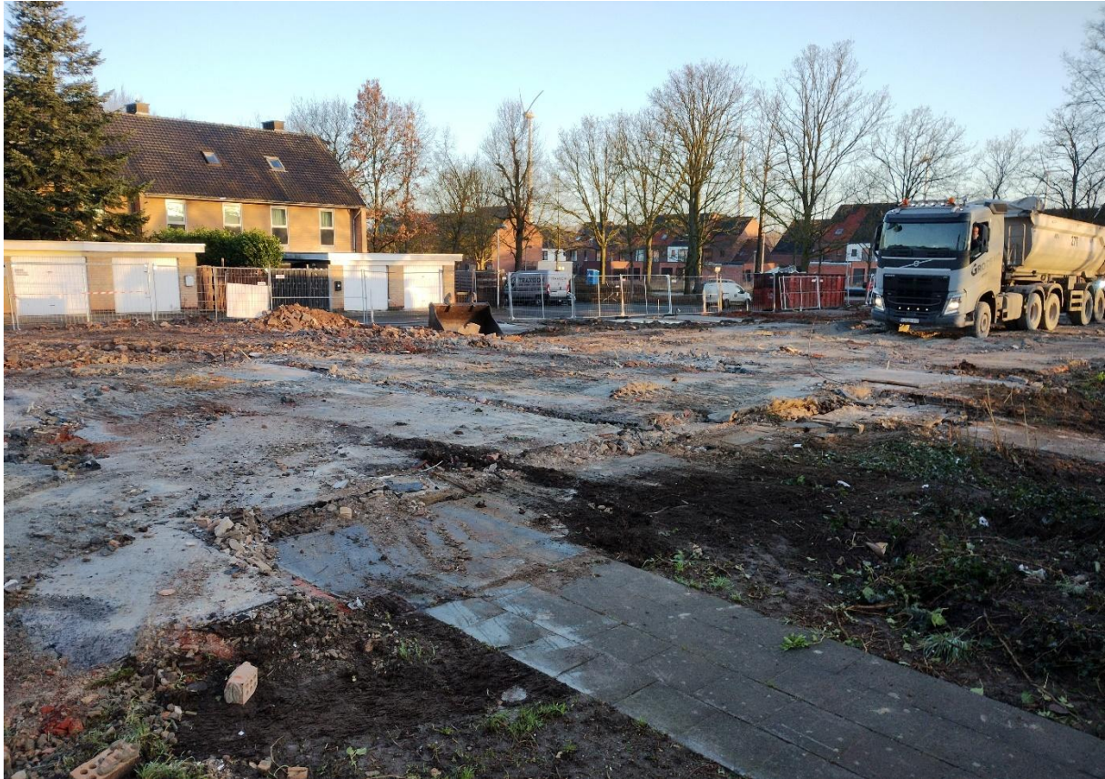
Figuur 16. Zicht op de betonplaat van gewapend beton van de voormalige woningen (Fase 1).
