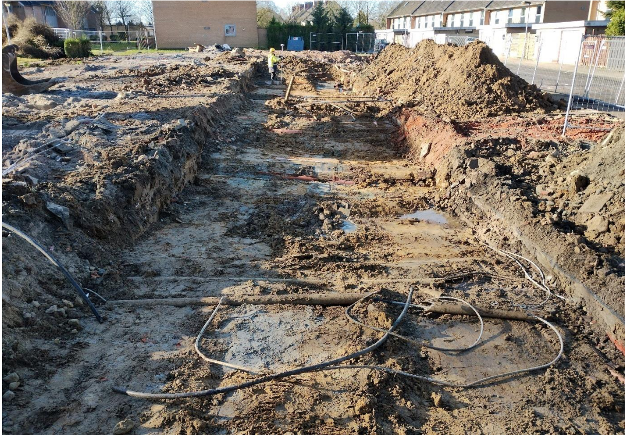
Figuur 44. Overzichtsfoto van proefsleuf met de nutsleidingen (asbest). (Fase1)
