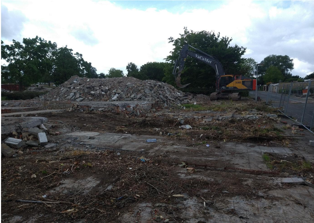
Figuur 20. Zicht op locatie werkput 14 voor aanvang (fase 3).
