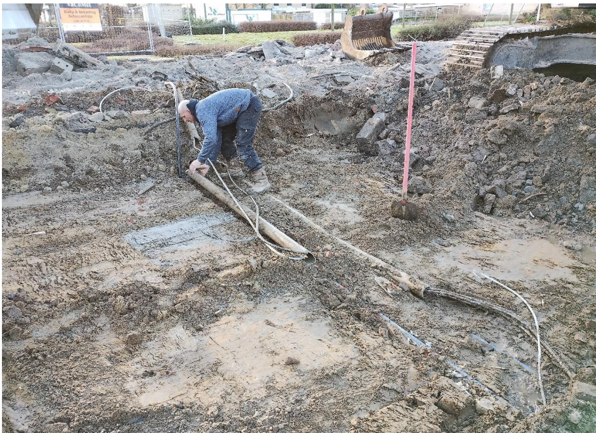
Figuur 45. Asbestbuizen in proefsleuf 1.
