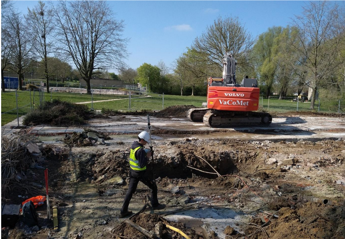
Figuur 18. Zicht op het afgebroken bouwblok in het noordwestelijke deel (op de voorgrond de locatie van WP5) (fase2).
