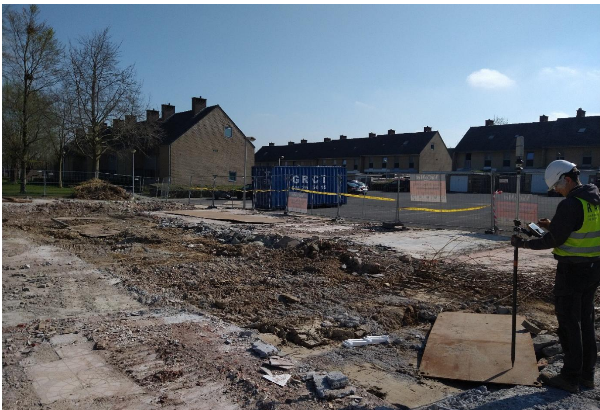
Figuur 19. Zicht op het afgebroken bouwblok in het noordwestelijke deel (op de voorgrond de locatie van WP8) (fase2).
