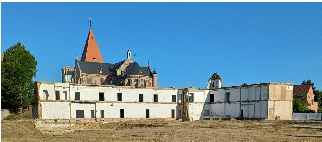
Figuur 5: Zicht op de nog bestaande bebouwing op het terrein
