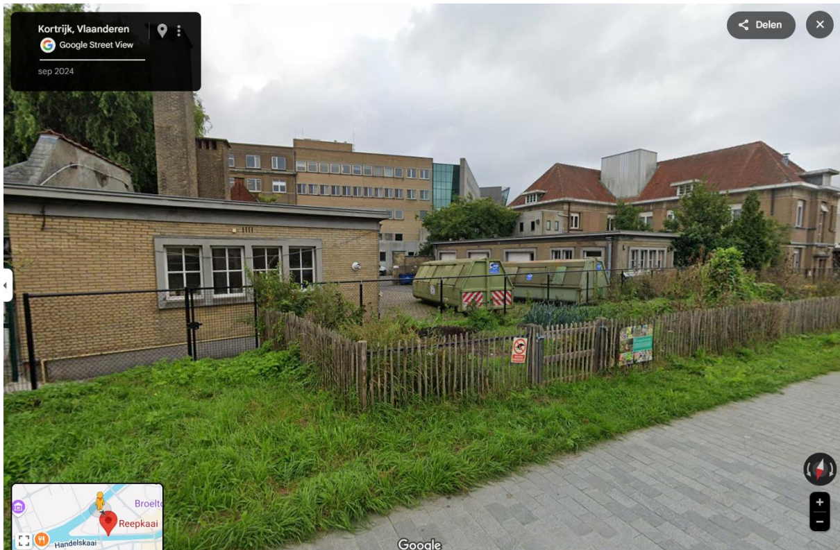
Figuur 3: Zicht op het plangebied vanaf de Reepkaai met op de voorgrond twee te slopen volumes. 9
