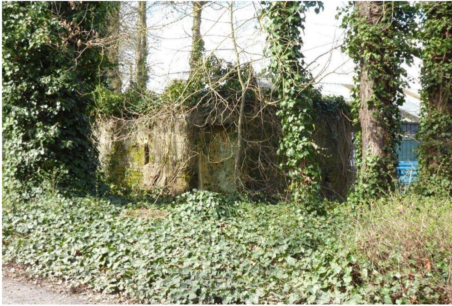
Figuur 33. Vooraanzicht van bunker E7. 21
