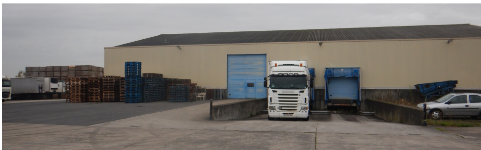
Figuur 9. De moderne loodsen.
