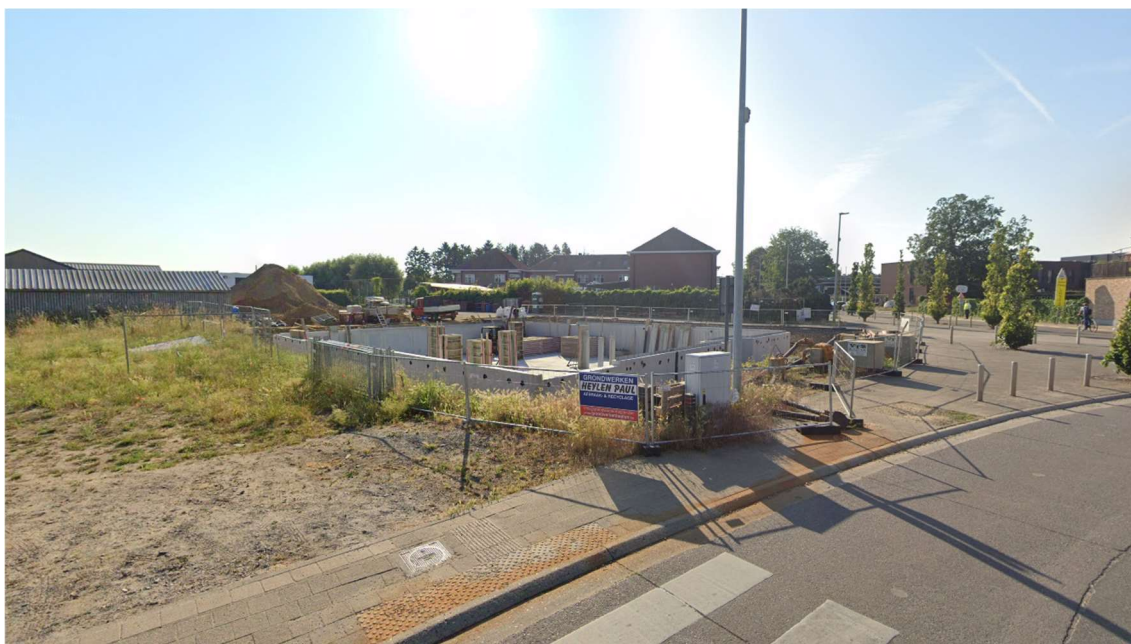
Fig. 1.7: Zicht op de kelder van de woning (© Google Maps, juni 2023).
