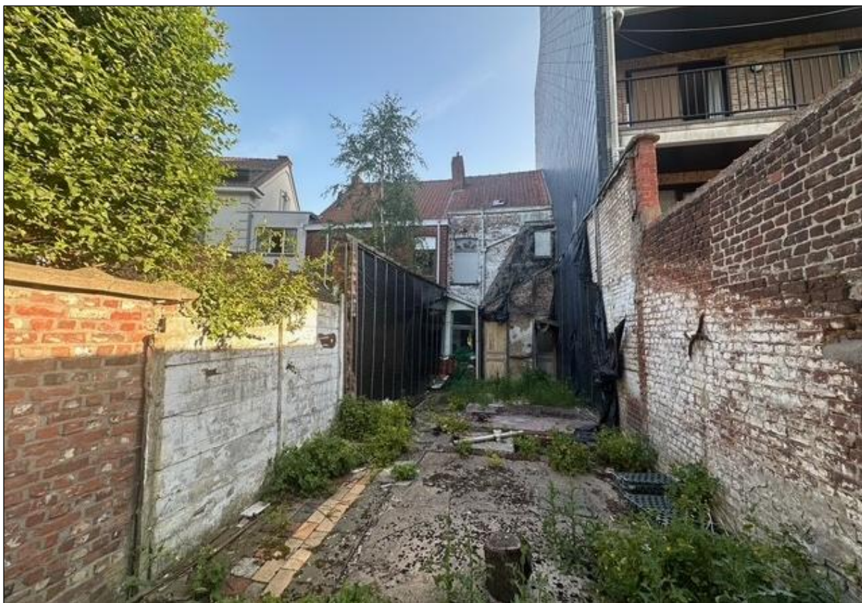
Figuur 6 Zicht op de achtertuin van de woning aan de Waalvest 25 (bron: initiatiefnemer, foto 6).
