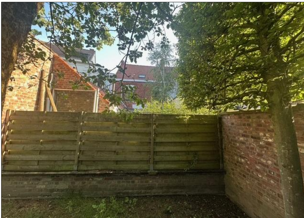
Figuur 5 Zicht op enkele scheidingsmuren in de achtertuin van Waalstraat 25 (bron: initiatiefnemer, foto 5).
