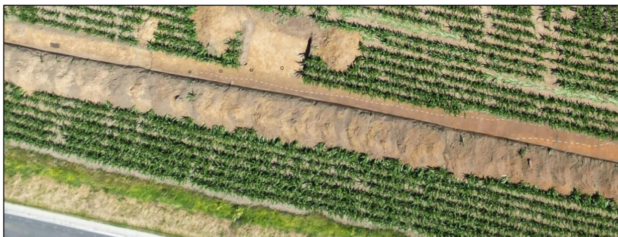
Figuur 49 Dronefoto van S01-S02-S03-S04 en S18 in WP1 en KV1 (ABO nv 2025)
