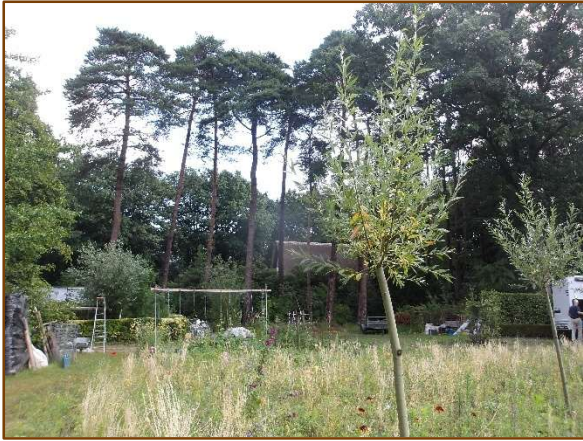
Figuur 29: Centrale deel - zicht op sloopzone Z naar N (bron: AIR)
