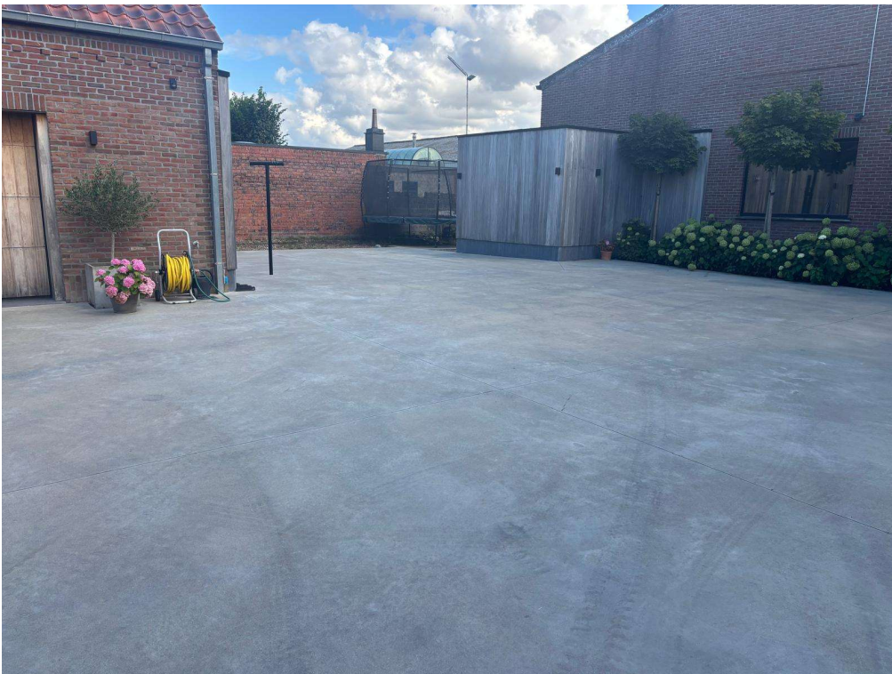
Figuur 5: Zicht op de weegbrug en de betonverharding aan de woning. 7
