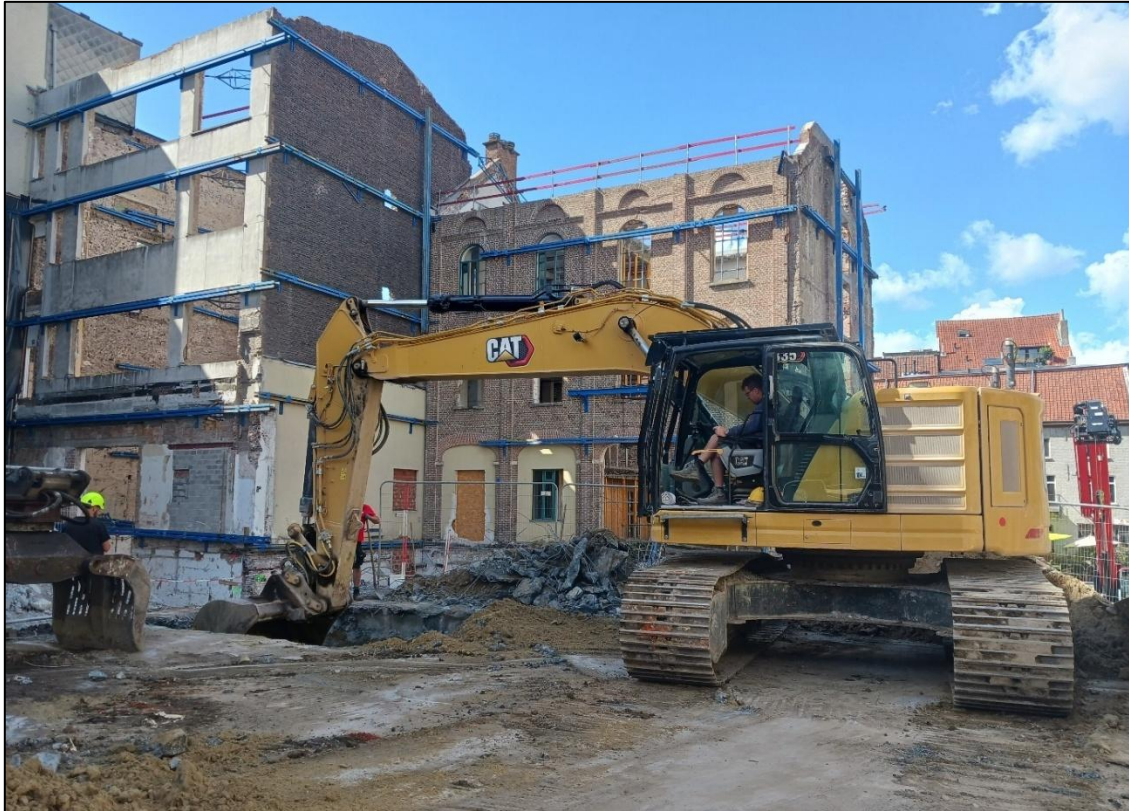
Figuur 8: Aanleggen van werkput 2.
