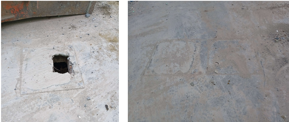
Fig. 2.9: Zicht op de verstoringen aangebracht door de septische put en de aansluitingen op de riolering in de noordelijke zone.
