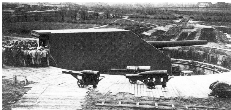
Figuur 2 Personeel van de batterij krijgt onderricht bij de enige gepantserde geschutstoren, die tevens de enige van de vier 38 cm kanonnen was die een elevatie had van maximum 55 graden. (Ryheul Johan, 2022)
