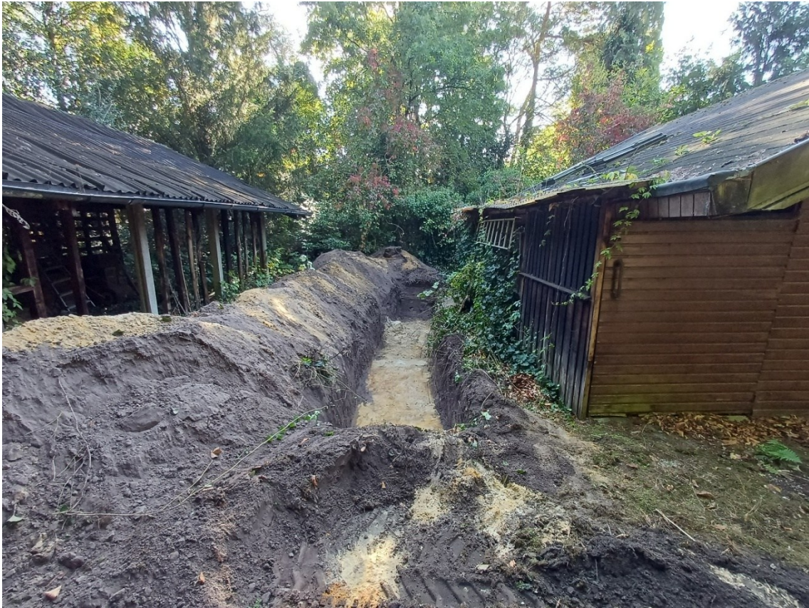
Figuur 23: Werkfoto proefsleuf tussen twee bijgebouwen op het terrein
