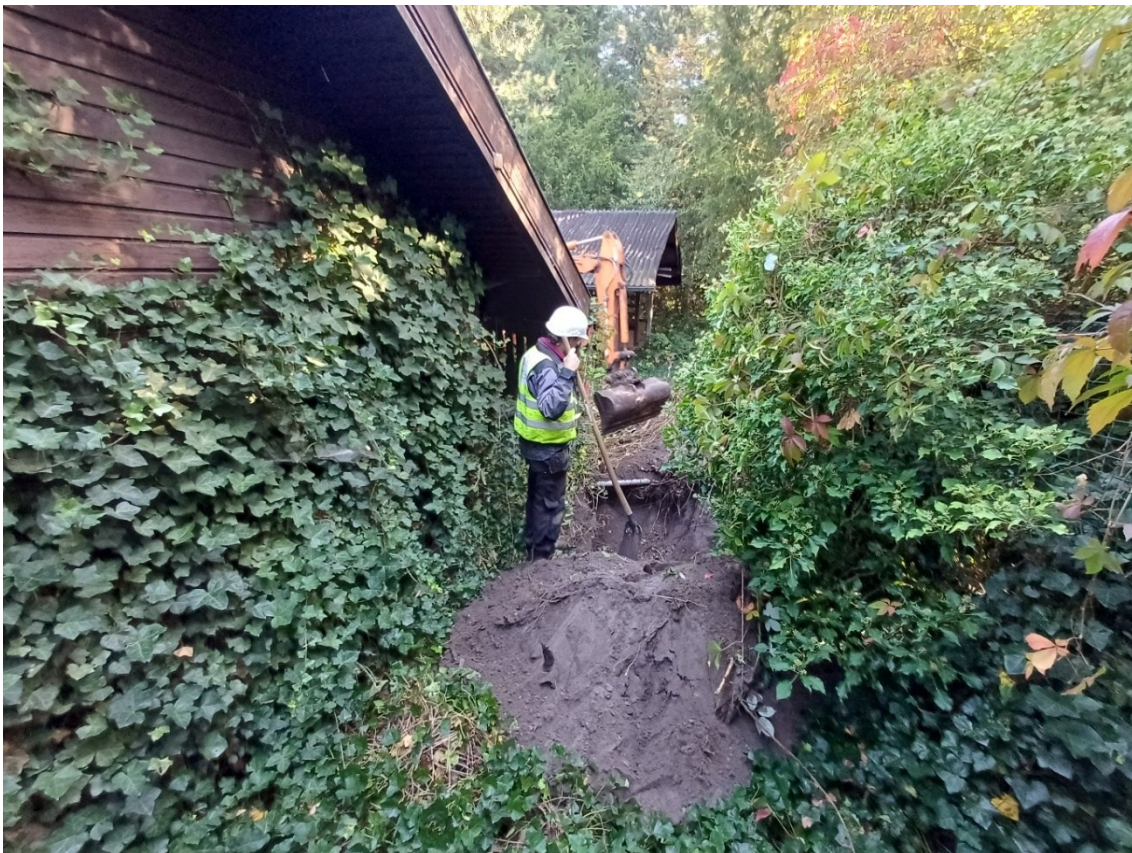
Figuur 22: Werkfoto aanleg proefsleuf langs bijgebouw
