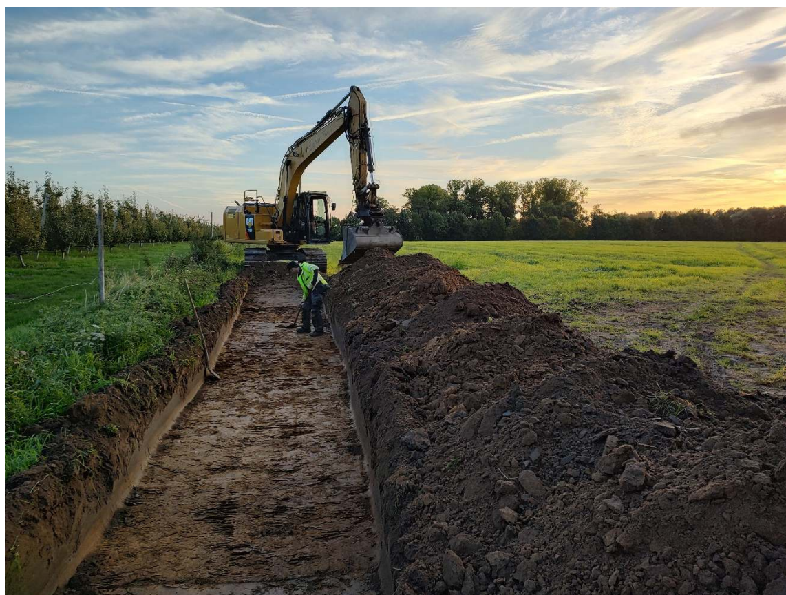
Afbeelding 15.4.2.2: Impressie van de aanleg van de werkput.
