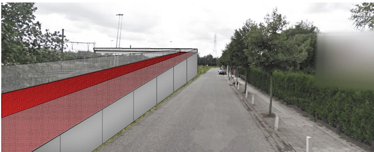
Figuur 1.1-37 Zicht op landhoofd met keerwanden.
