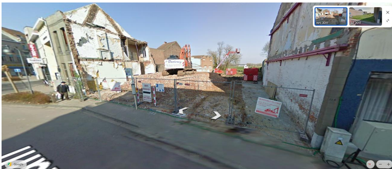
Figuur 35 Foto van de afbraak van de vijf huizen op percelen 1296S, 1296R, 1296V, 1296P en 1296W in 2011. Bron: Google Streetview, geraadpleegd via Google Earth, opnamedatum maart 2011.
