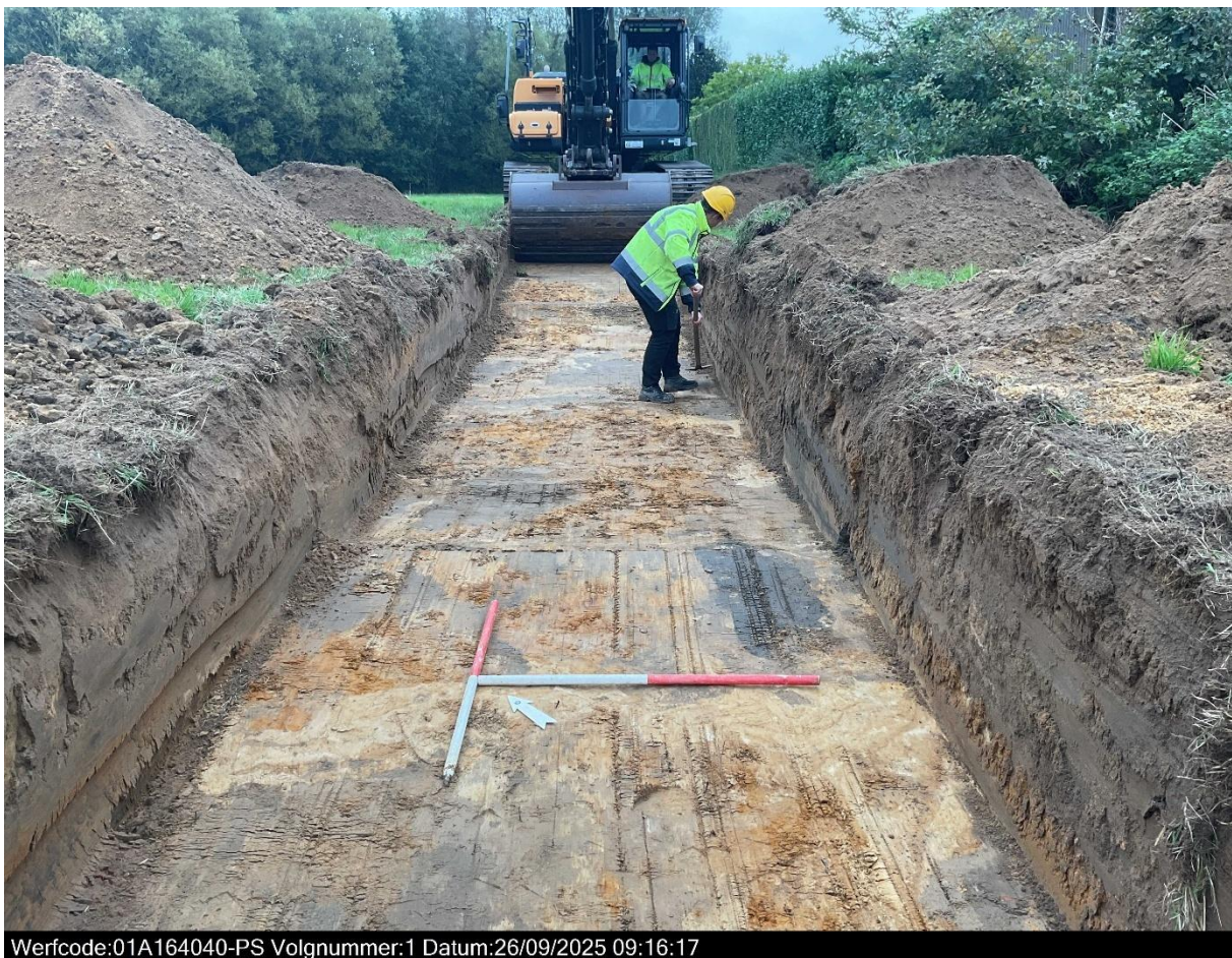
Figuur 27: Overzichtsfoto tijdens de werkzaamheden: aanleg van proefsleuf 1.
