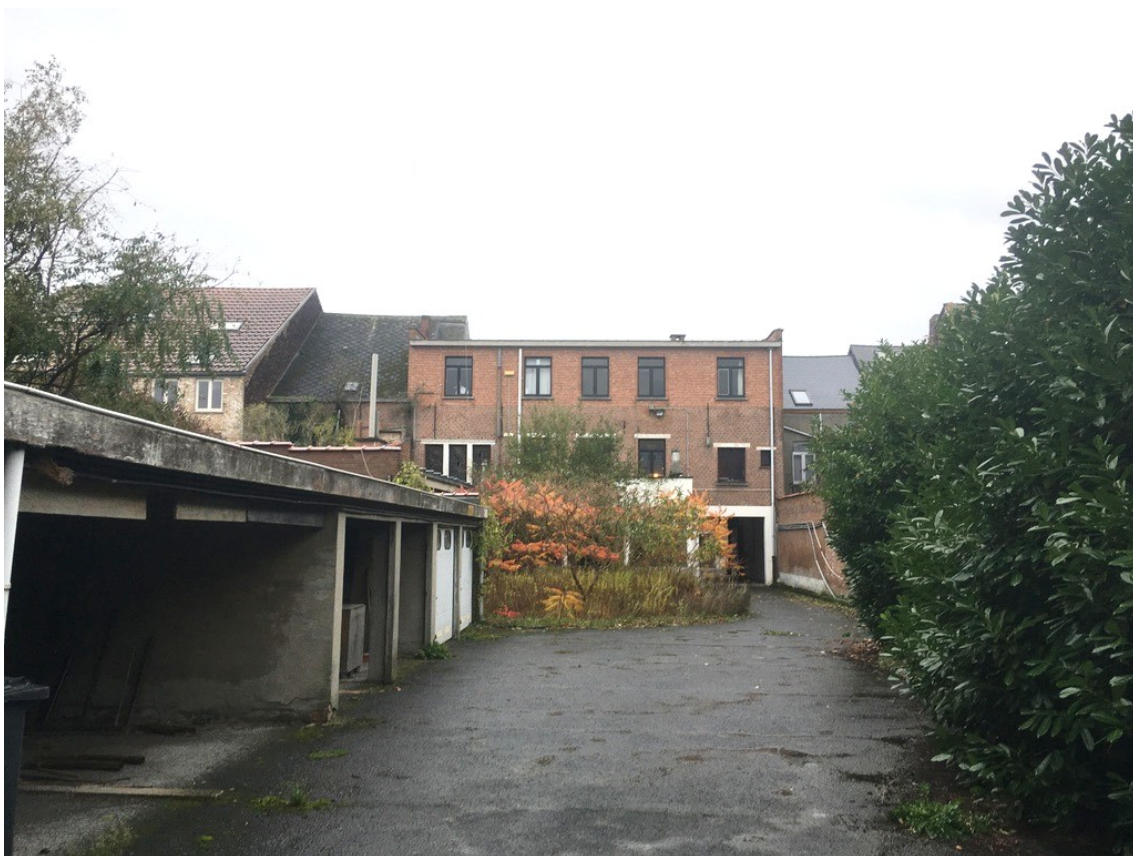
Figuur 5: Zicht op de woning Nekkerspoelstraat 273
