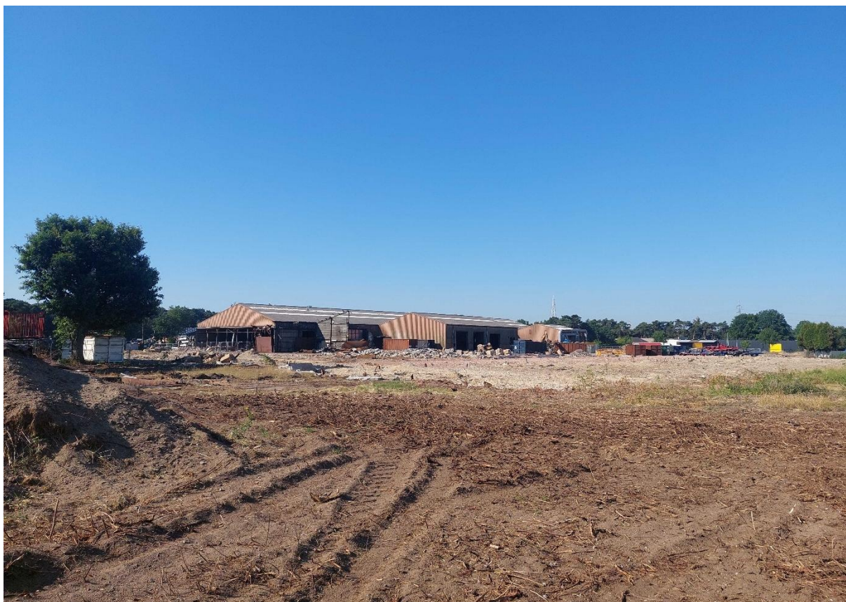
Figuur 7: Zicht richting de overgebleven gebouwen vanuit het noordoosten.
