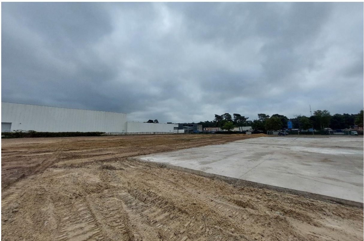
Figuur 11: De te behouden betonplaat tijdens fase 2 van het onderzoek (gezien vanuit het noorden).
