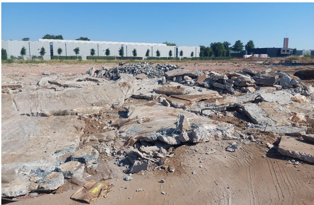
Figuur 8: Gedeeltelijk opgebroken verharding aansluitend bij het resterende gebouw.
