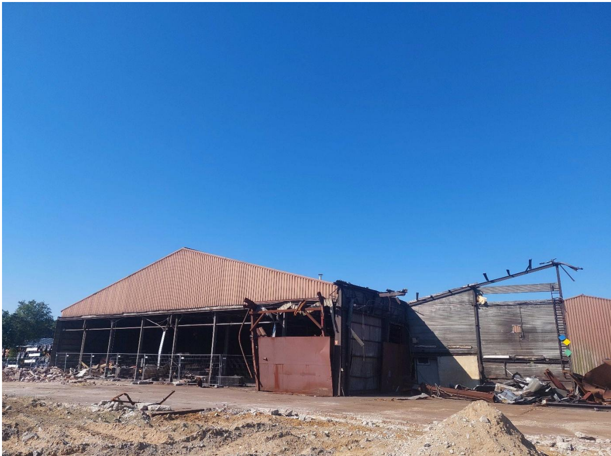
Figuur 6: De nog aanwezige gebouwstructuur gezien vanuit het oosten.
