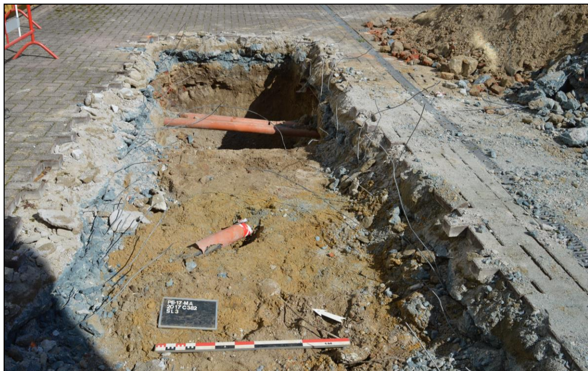
Afb. 35: Zicht op SL3 en PP2. Hier kon de moederbodem niet bereikt worden door de aanwezigheid van elektriciteitsleidingen en een afvoerbuiss (Bron: Aron bvba, dd. 27/03/2017, 2017C382).
