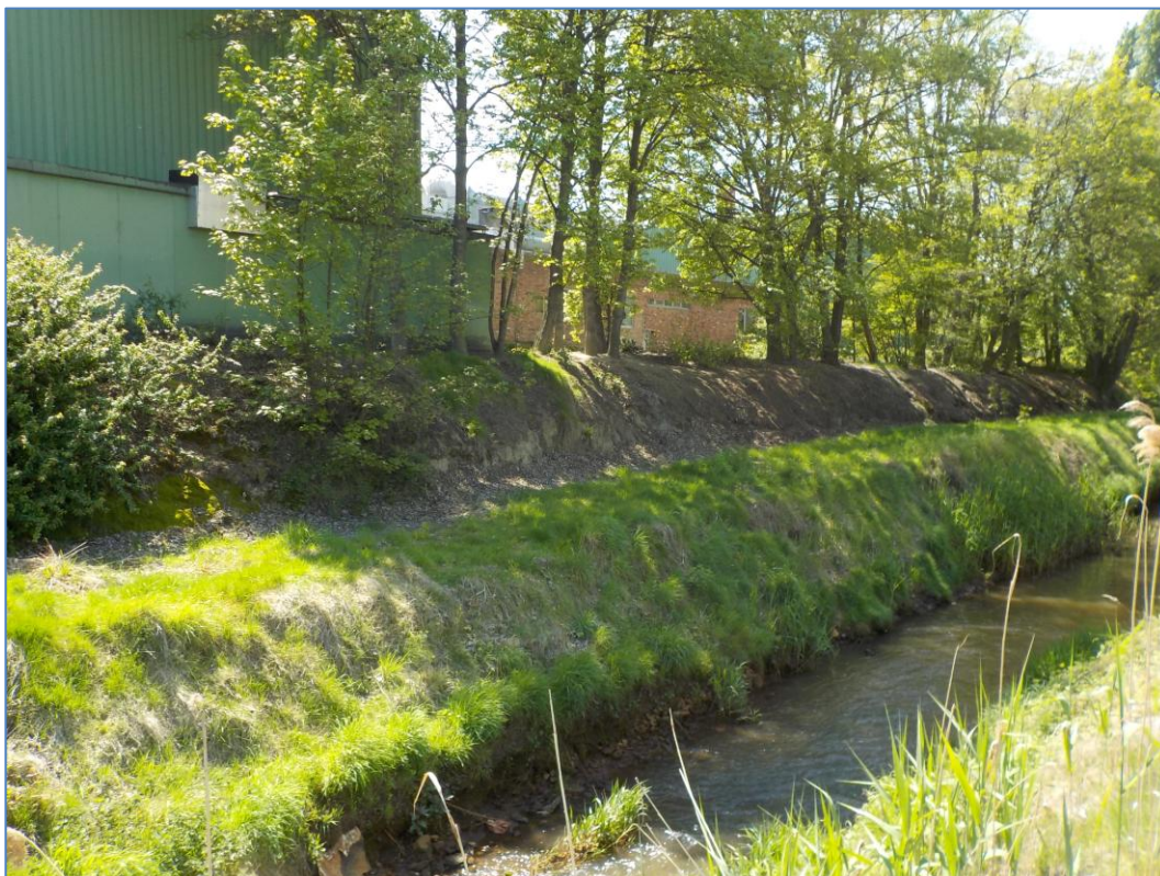
Afb. 31. Overzicht van het zuidelijke plangebied met de gekanaliseerde Laembeek. Duidelijk te zien is de 2,5m dikke ophogingslaag waarop de gebouwen van dit industrieterrein staan (11-05-2017). De lagere grasstrook naast de Laembeek is het oude oppervlak
