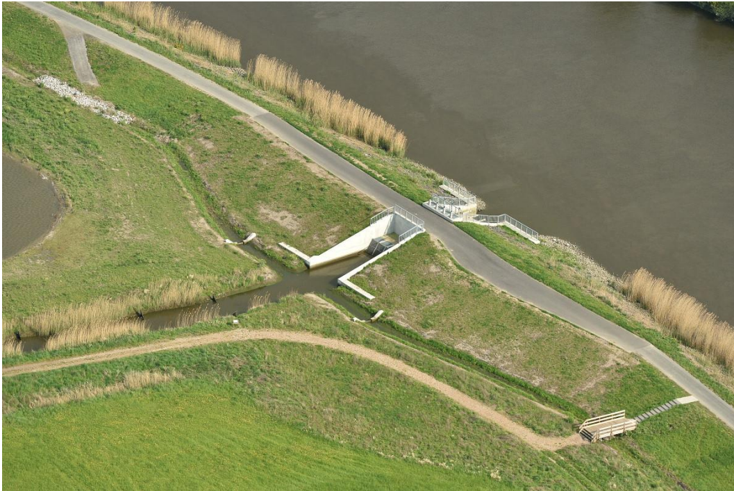
Figuur 3-2: Luchtfoto uitwateringsstructuur Paardeweide
