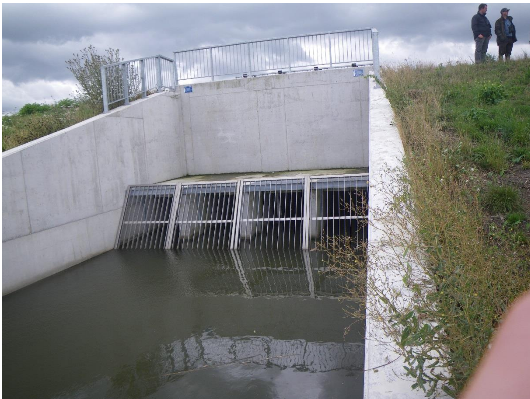
Figuur 3-3: Aanzicht langs GOG-zijde van een gelijkaardige kokerconstructie te Paardeweide (Berlare en Wichelen), evenwel met 4 kokers
