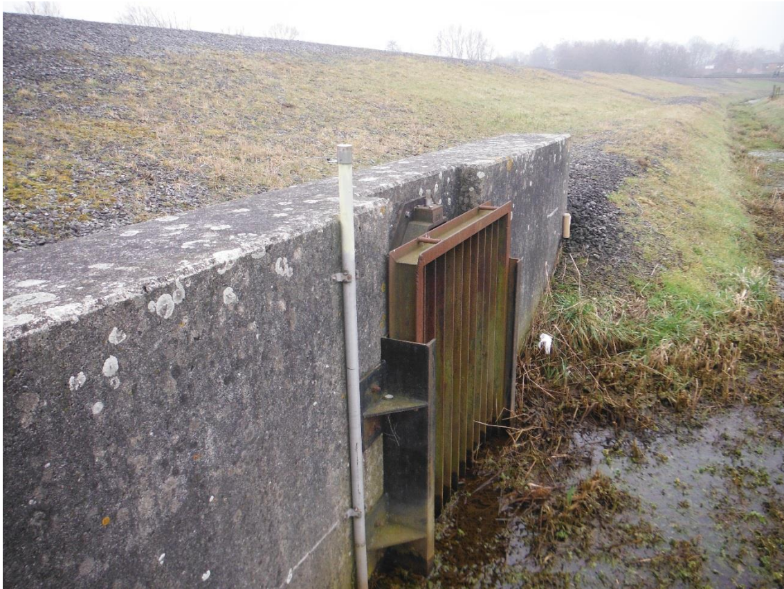
Figuur 4-2: Kopmuur bestaande uitwateringskoker
