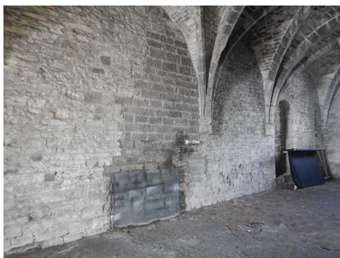
Figuur 10. In wijzerszin: een dichtgemetste watertrap in de zuidoostelijke hoek van de crypte; een obsolete toegang in de noordwestelijke hoek; verschillende herstelwerken in de zuidwestelijke hoek nabij de toren.
