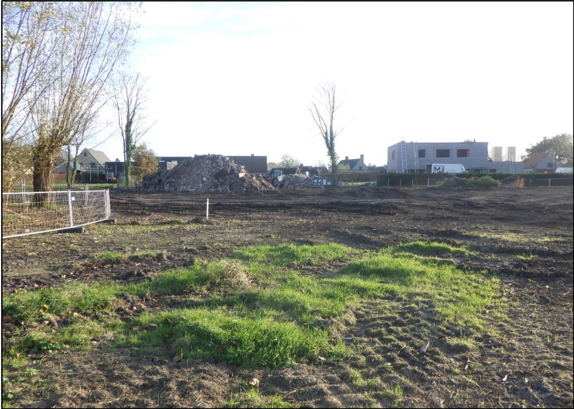
Figuur 11 Zicht op het zuidelijk deel van het terrein na de bovengrondse sloop.
