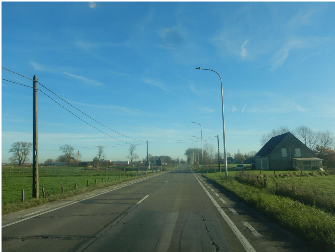
Fig. 1.17: Huidige toestand Deinsteenweg met links en rechts een voorbeeld van de te dempen grachten (© initiatiefnemer).
