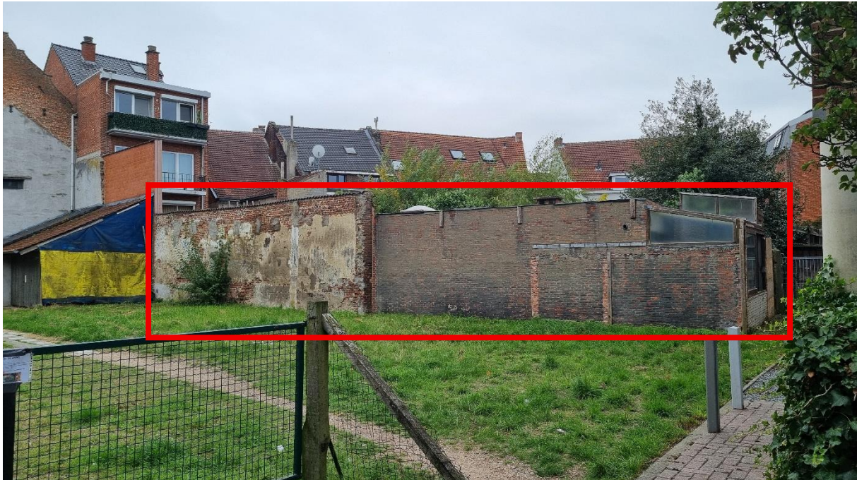
Fig. 45: zijgevel van de af te breken achterbouw op perceel B348L
