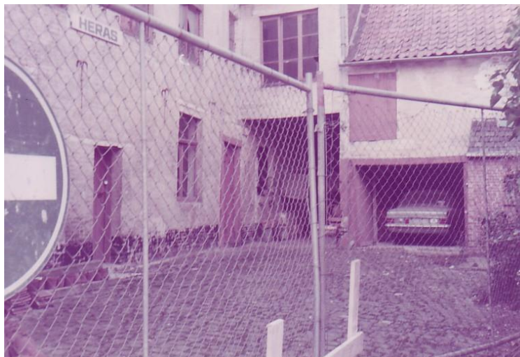
Fig. 38: Foto's van de achterbouw op het kadastraal perceel B350v, (sloopdossier stad Bree, dienst omgeving 1981/46) genomen bij de afbraak van de woningen Markt 4 en 6, beide afgebroken in 1965 en situering van die achterbouw op de Wateratlas uit 1883.
