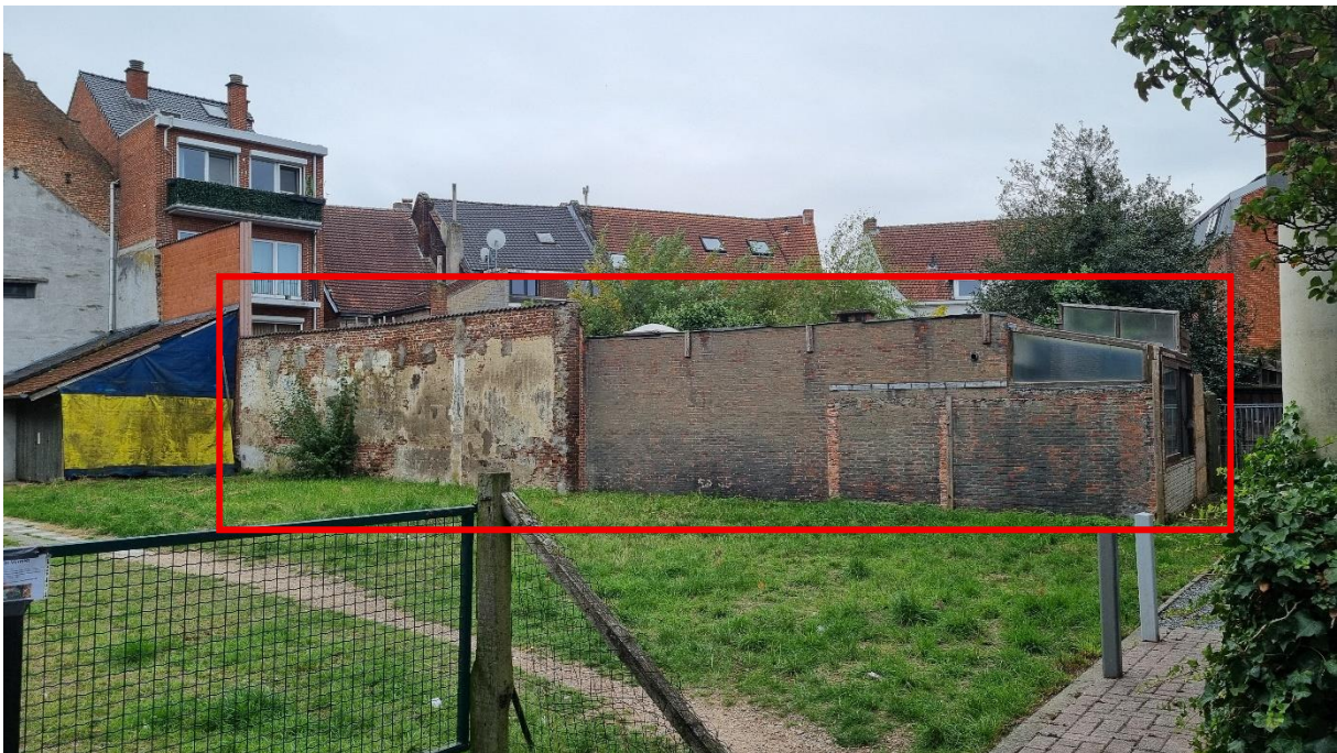
Fig. 13: af te breken gebouw op perceel B348L
