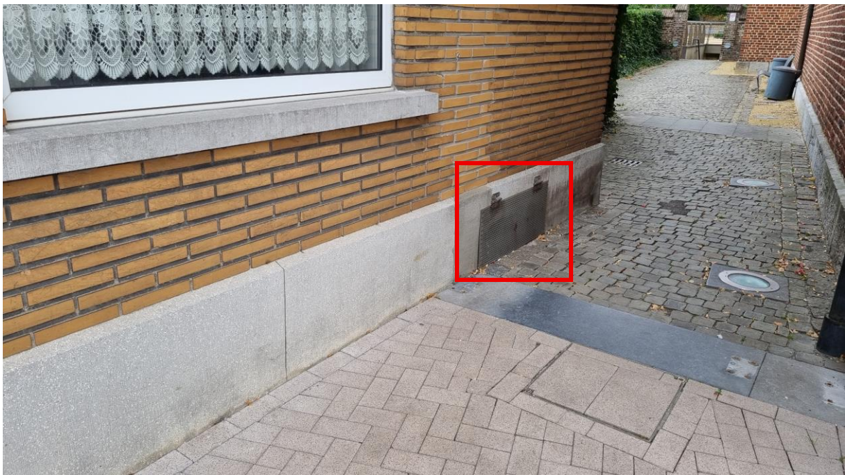
Fig. 11: Keldergaten – verluchtigingsgaten – aan de zijgevel en voorgevel van het pand op perceel 356g, huisnr Vrijthof 11 en putdeksels in de doorgang naar de achterliggende tuinen
