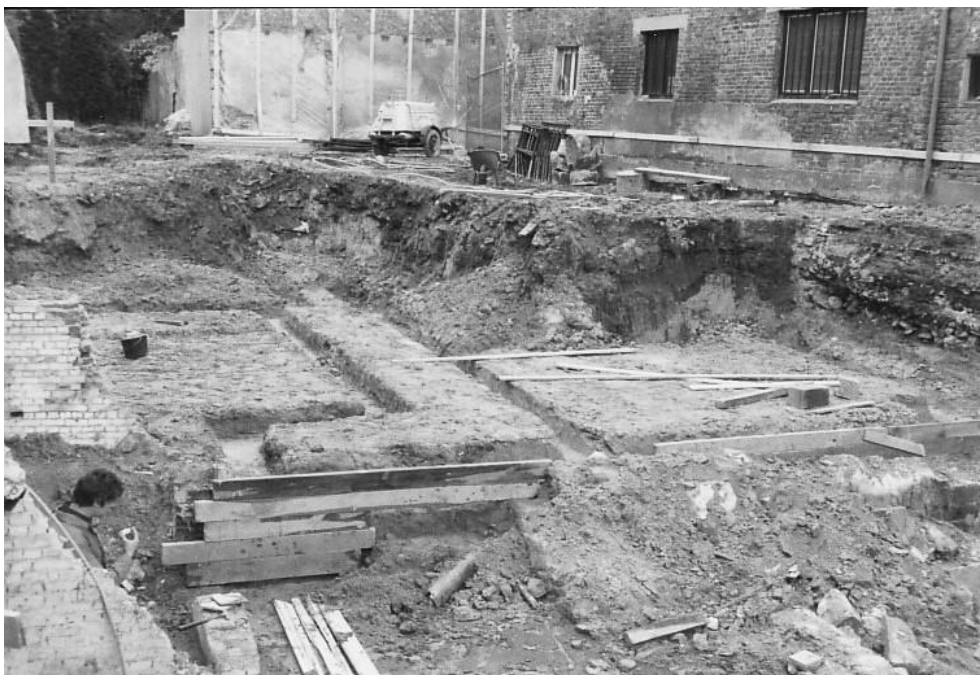
Fig. 43: foto's van de onderschoeiingen onder de fundering van het af te breken pand op perceel 356f (Vrijthof 12-14) en de aanleg van (kelder)funderingen op perceel 355e (Markt 6)
