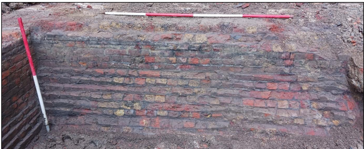
Figuur 18: Muur S1008
