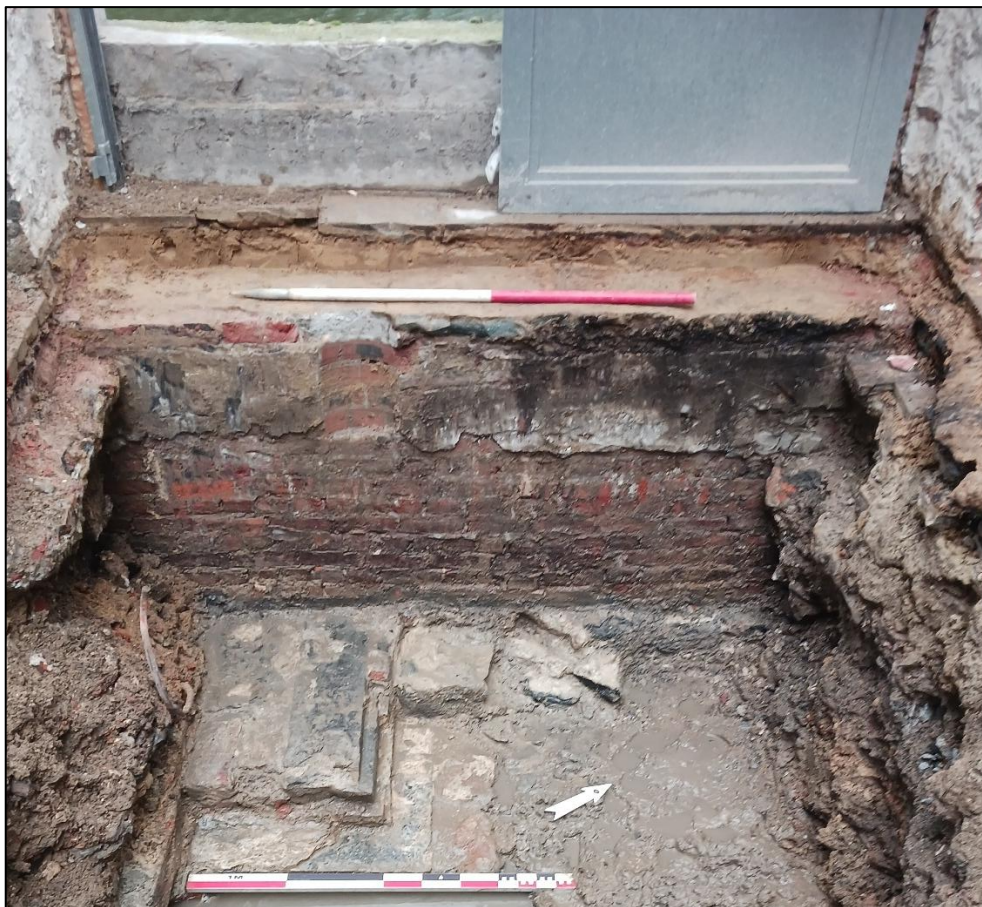
Figuur 14: Bakstenen (S1001) en natuurstenen gedeelte (S1002) van de kaaimuur
