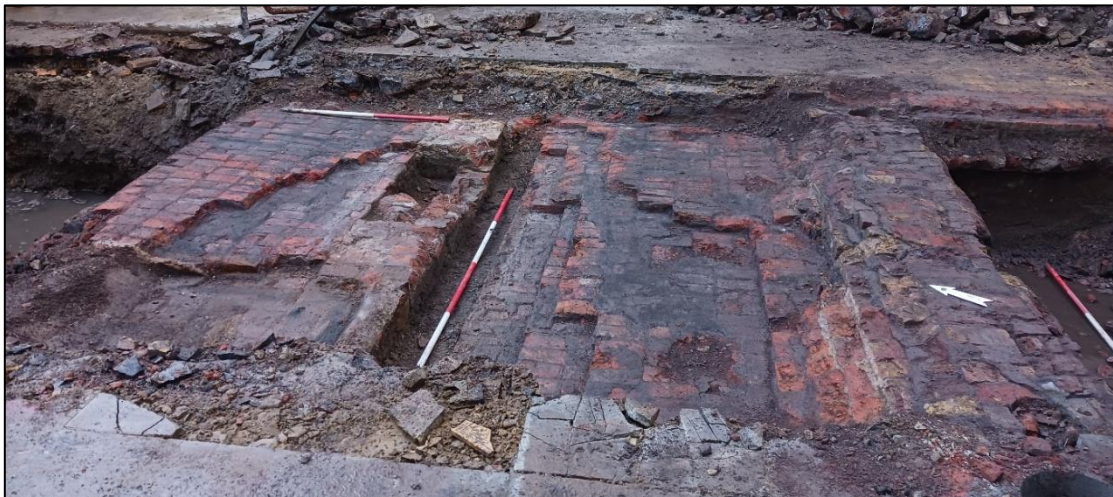
Figuur 15: Industriële funderingen S1003 (links) en S1004 (rechts)
