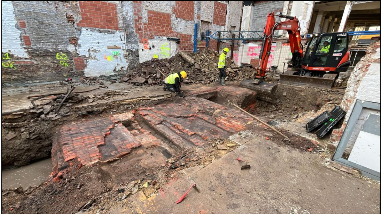
Figuur 10: Aanleggen van de proefput
