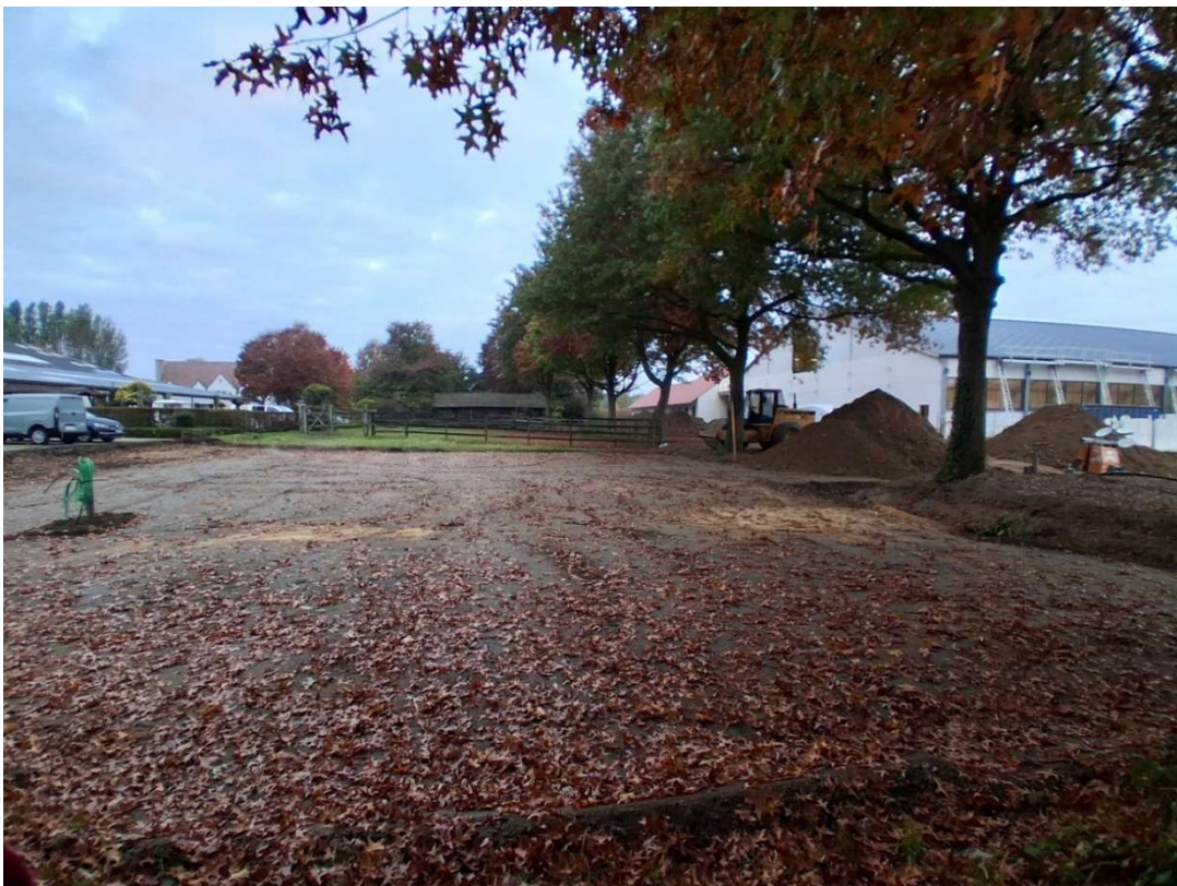
Figuur 8. Zicht op het terrein.
