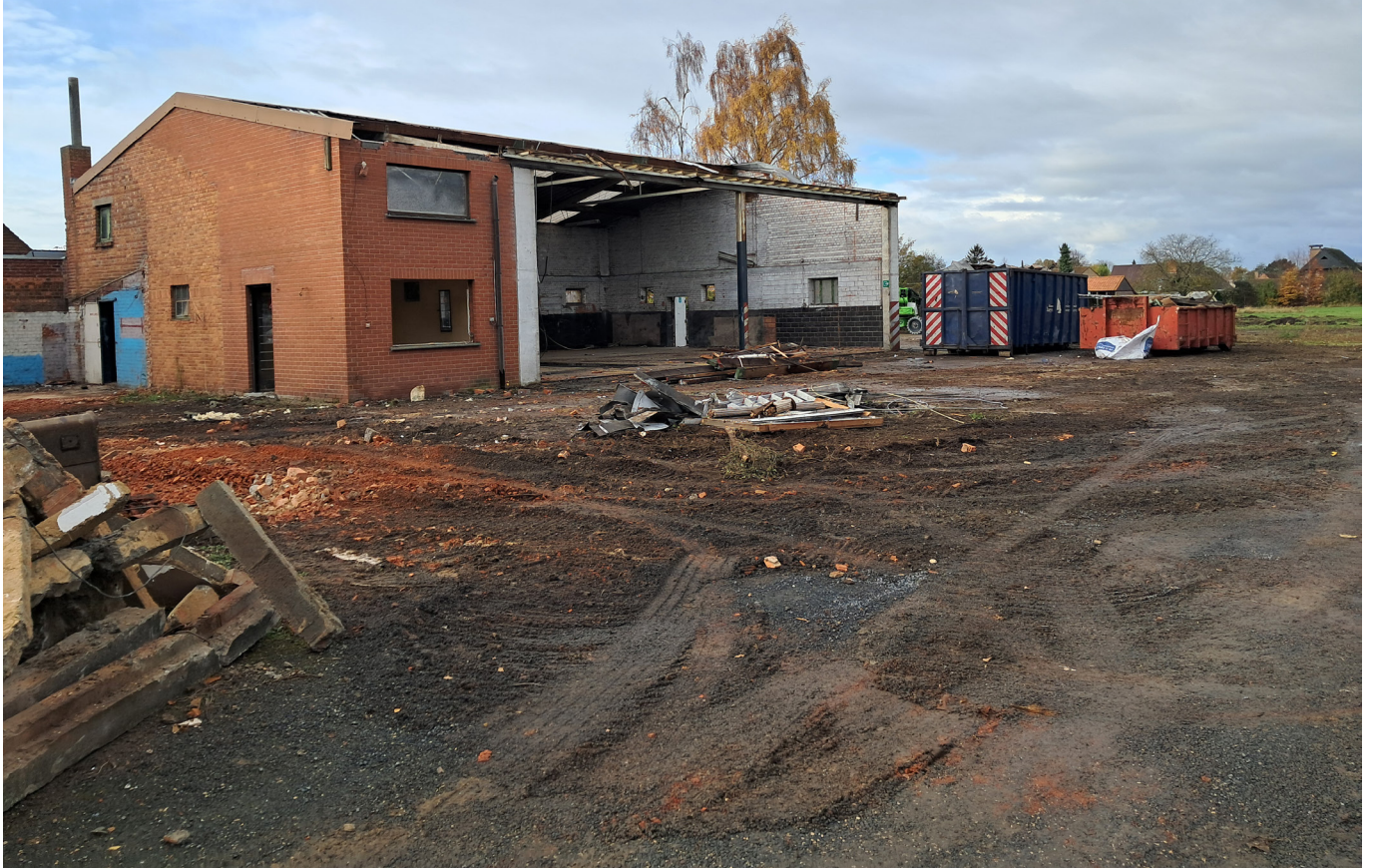
Figuur 5: Zicht op de afbraakwerken en ontoegankelijke zone in het zuidoosten
