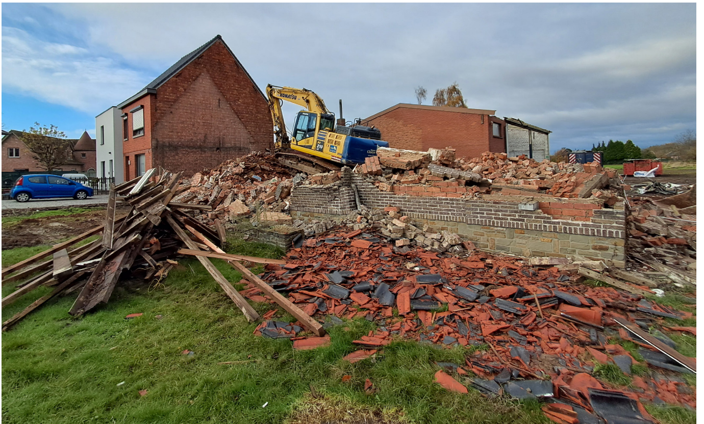
Figuur 6: Zicht op de afbraakwerken en ontoegankelijke zone in het zuidoosten
