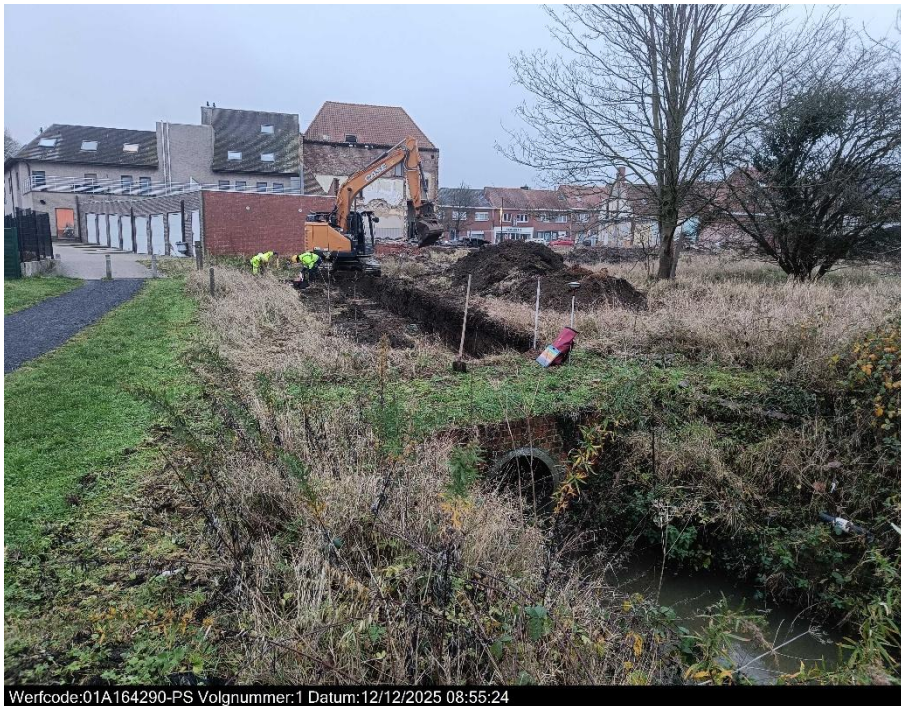
Figuur 5: Foto van de Zonnebeek die richting de dorpskern ingebuisd werd (zuidoosten) met op de achtergrond sleuf 1
