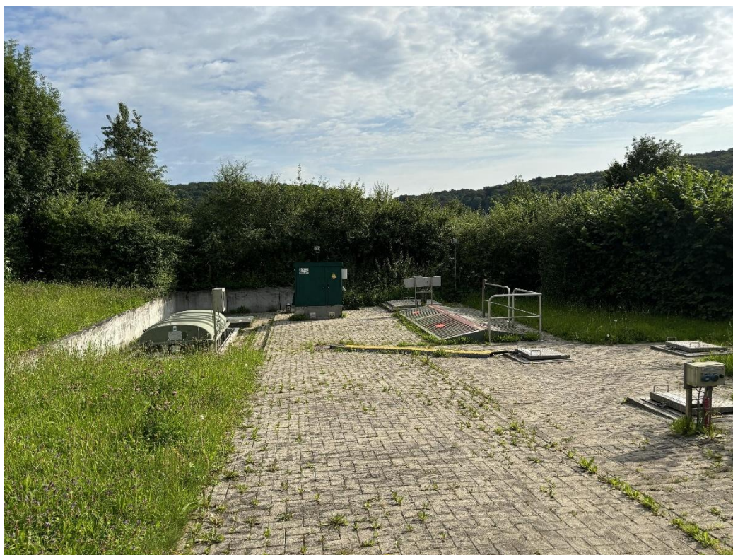
Figuur 8: Terreinfooto van de KWZI in Veurs (bron: initiatiefnemer)
