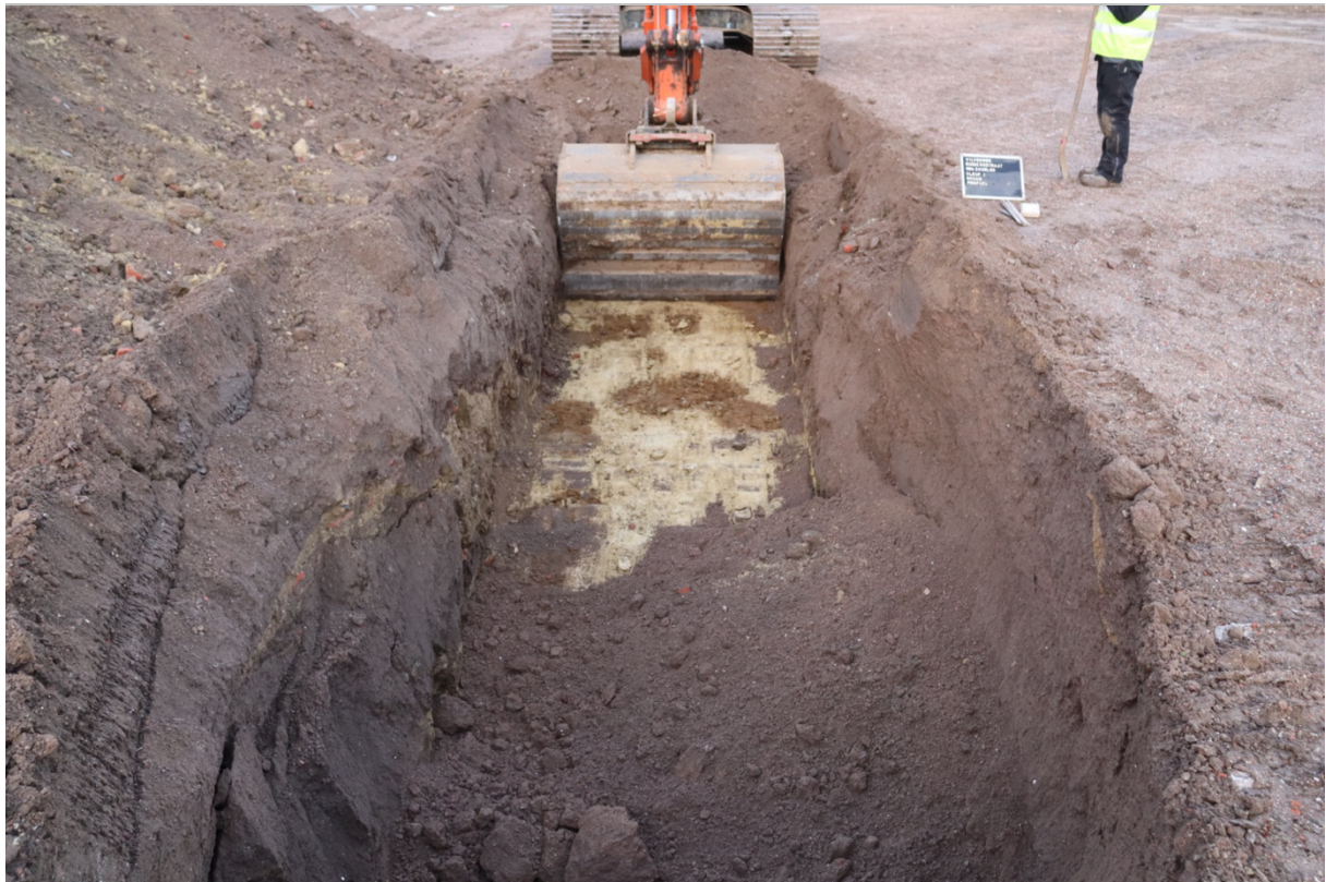
Fig. 2.7: Onstabiele sleufwanden in proefsleuf 1 tot op het tertiair sediment
