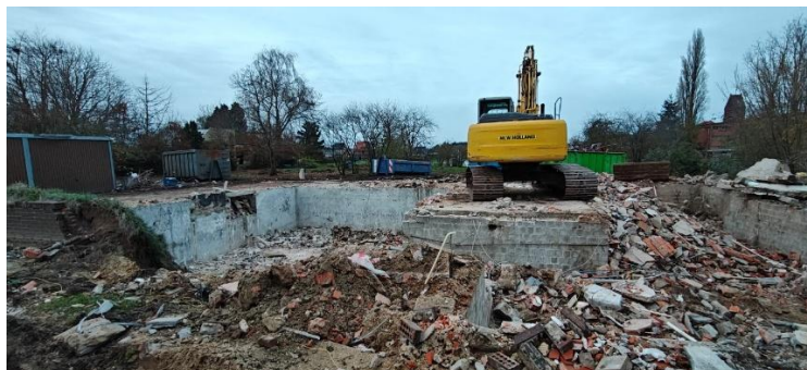
Figuur 20: Zicht op de zone van de gelijkvloerse plaat (boven) en de kelder (onder) voorafgaand de ondergrondse afbraak.
