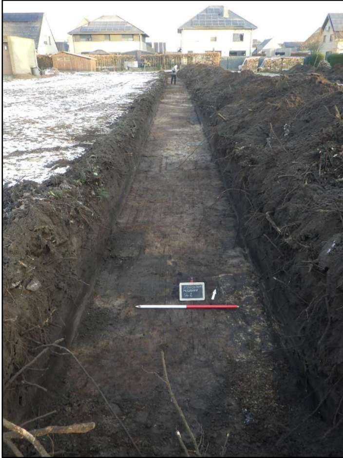
Figuur 25 Overzicht van sleuf 2.
