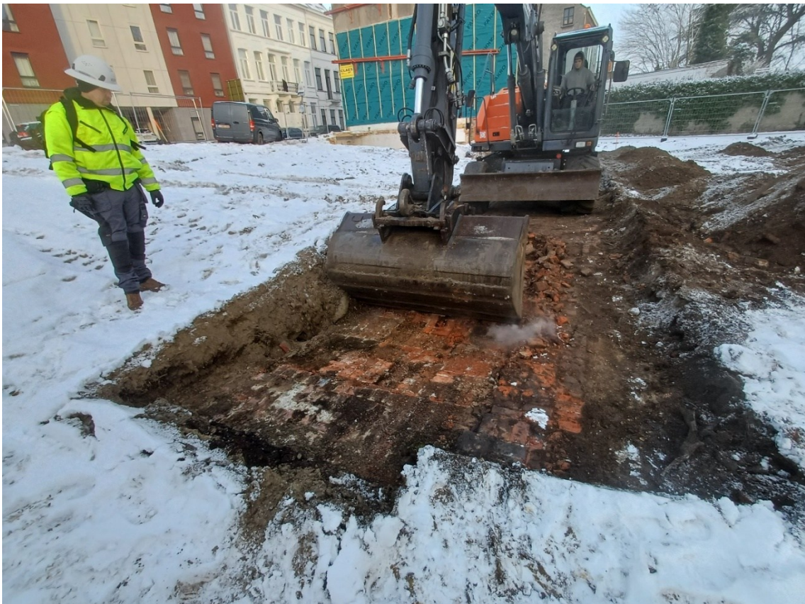
Figuur 13: Begeleiding uitgravingen door CTE-deskundige
