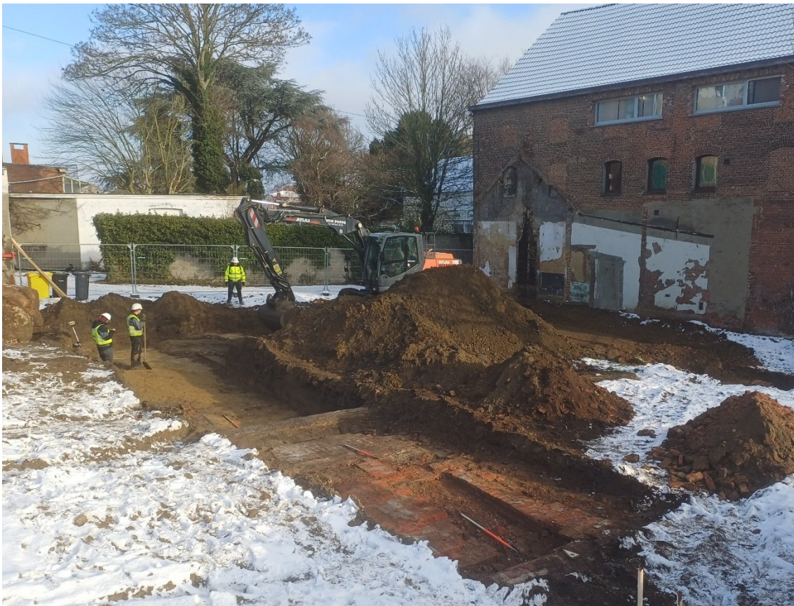
Figuur 11: Werkfoto van de aangelegde proefsleuven
