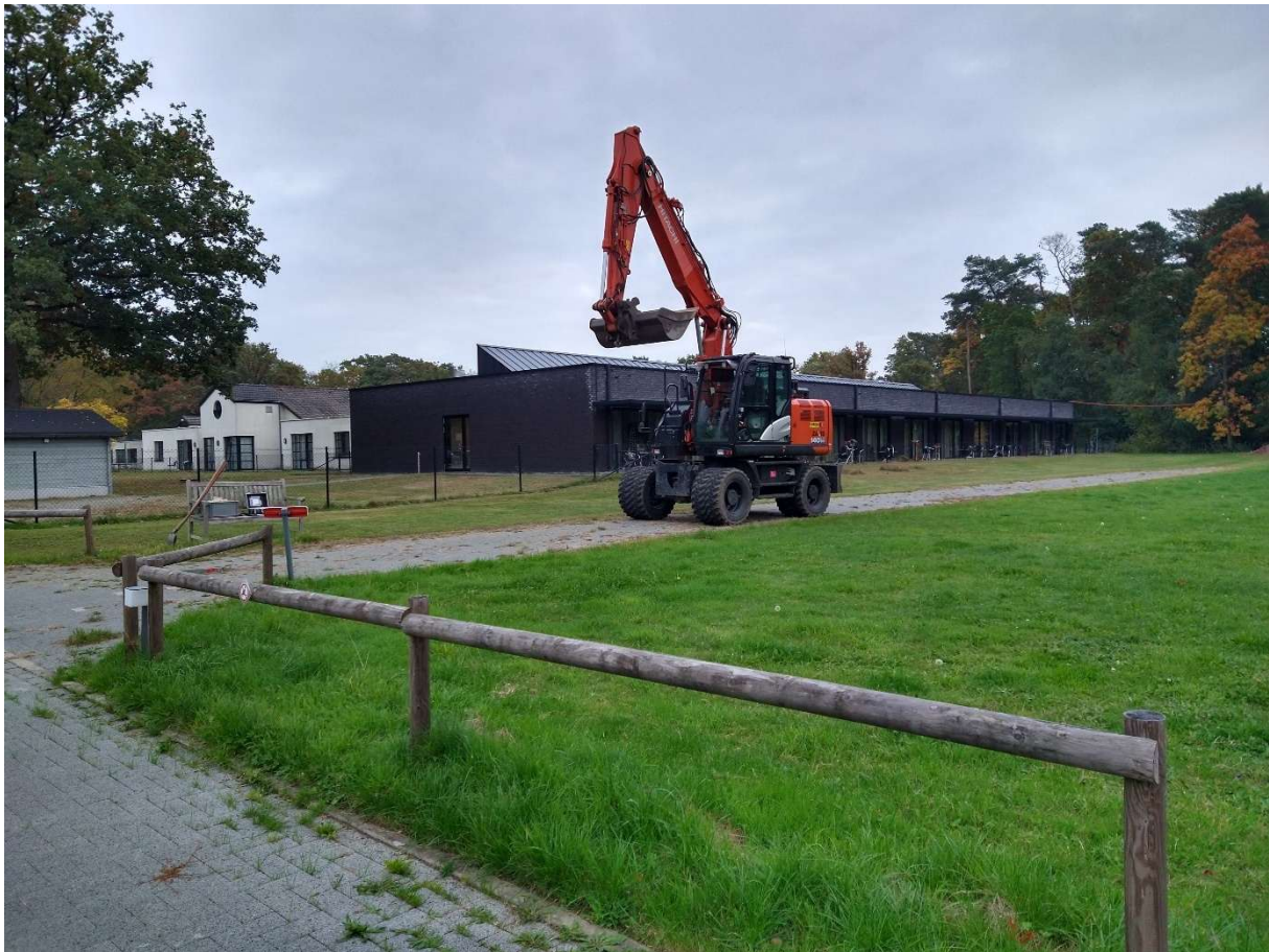
Figuur 7. Actieve brandweg en hek ter hoogte van proefsleuf 1.
