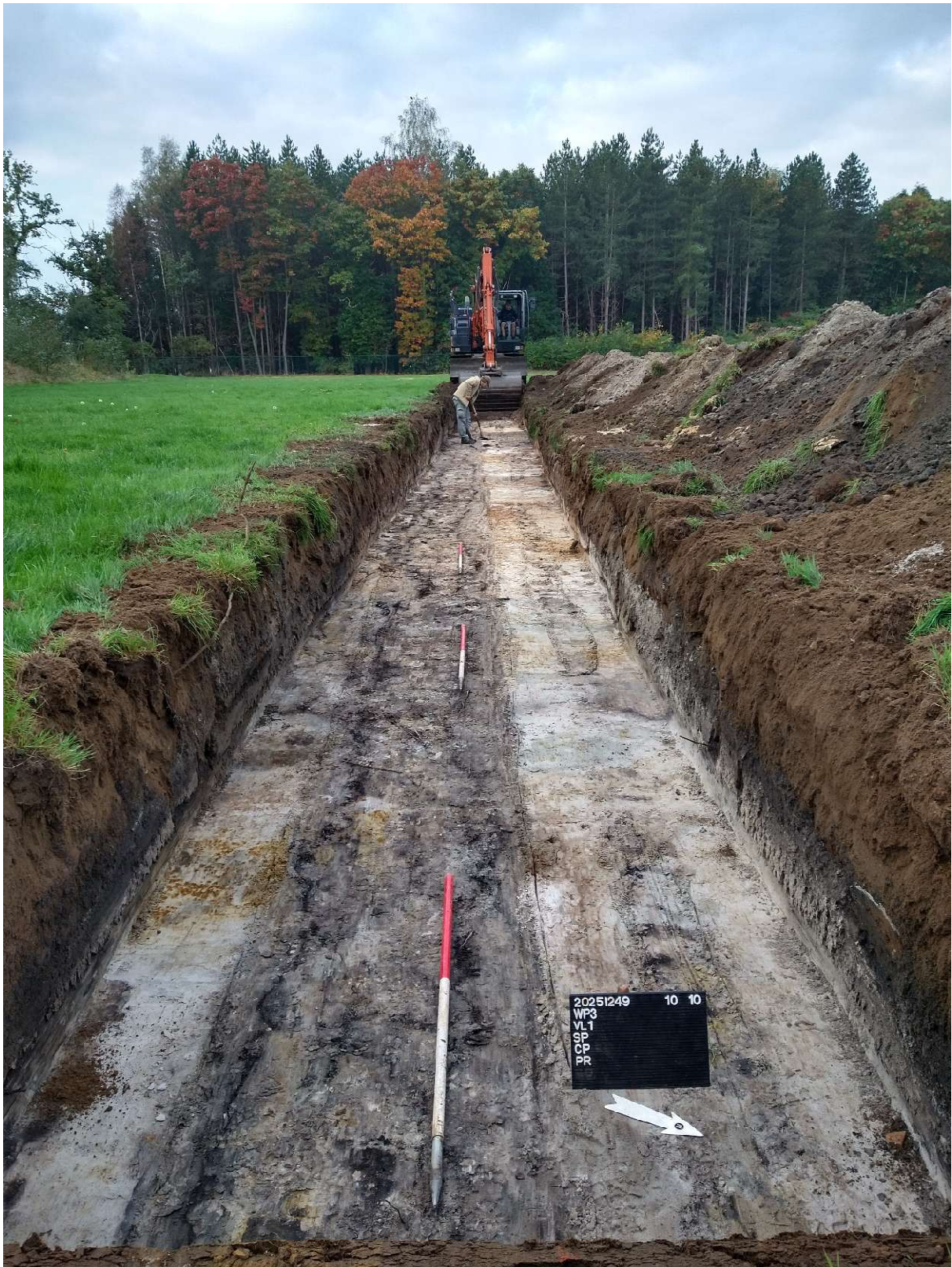
Figuur 17. Vlakfoto (overzicht) werkput 3.
